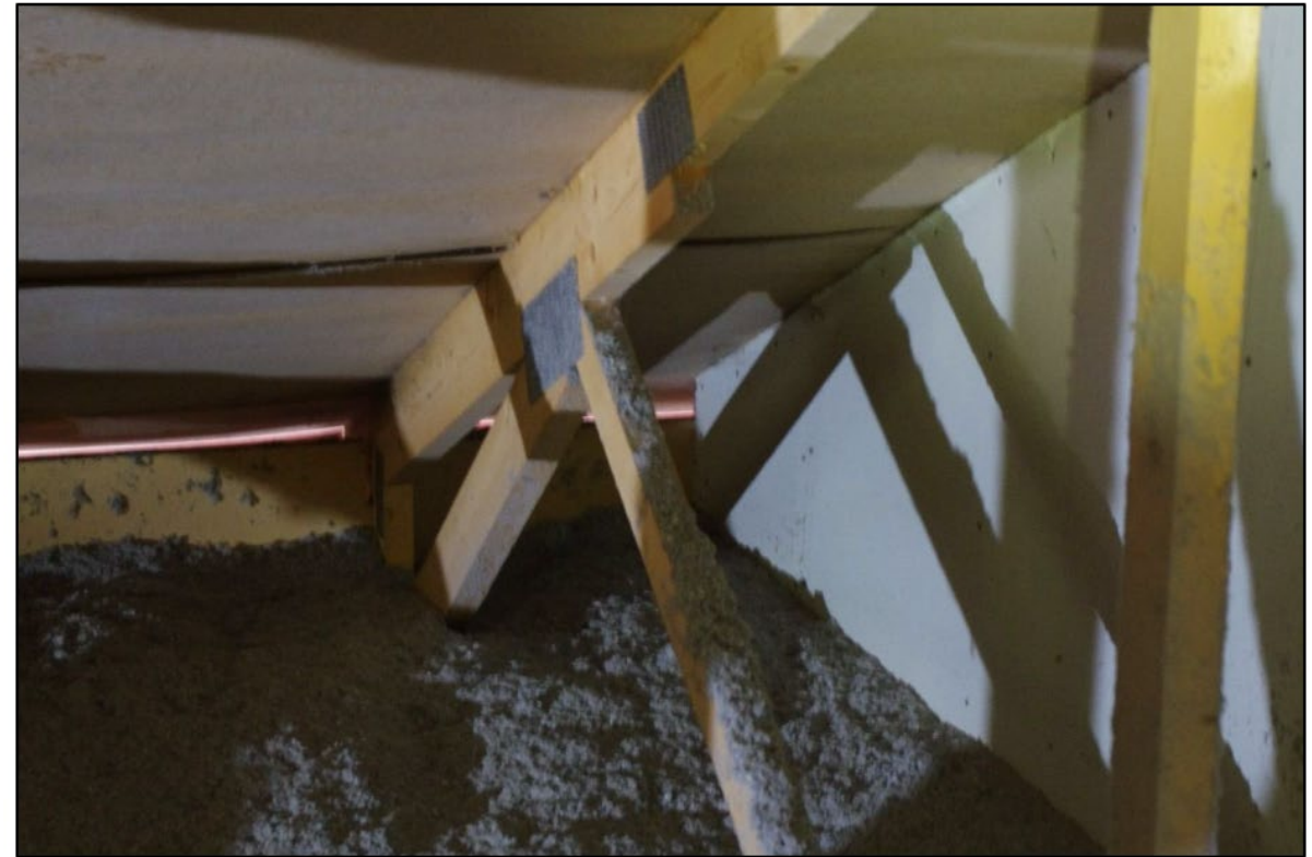
Kuva 4. Ullakon ontelon osastoinnin reuna
