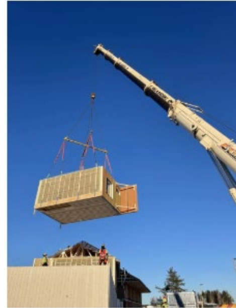
Tilaelementtien asennusta Keravan Kivisillassa 2023, kuva: Puukoti Group
