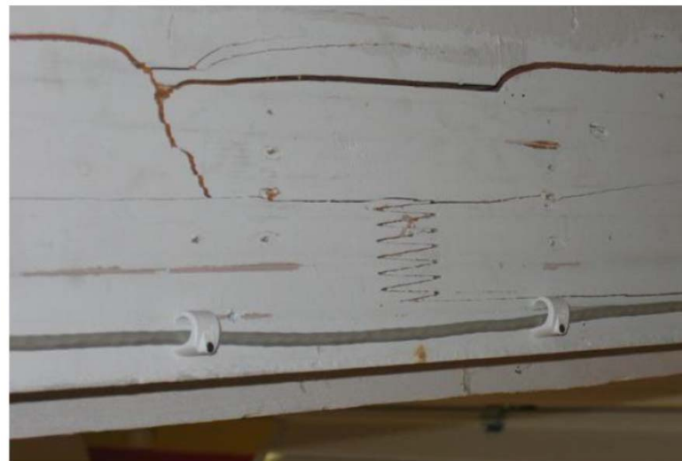
Liimapuupalkki; Limträbalk; Glued laminated timber beam
