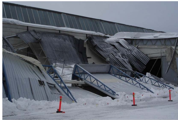
Teräskehä; Stållram; Steel frame (Kuva: Länsi-Uudenmaan pelastuslaitos)
