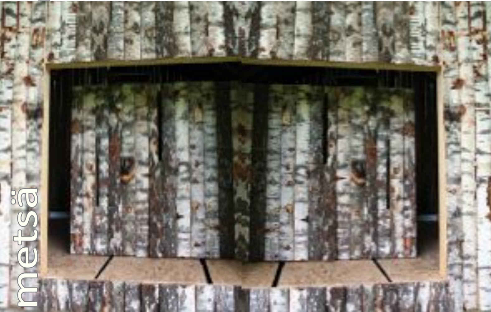
Haus Maarit, Kessel, Saksa
