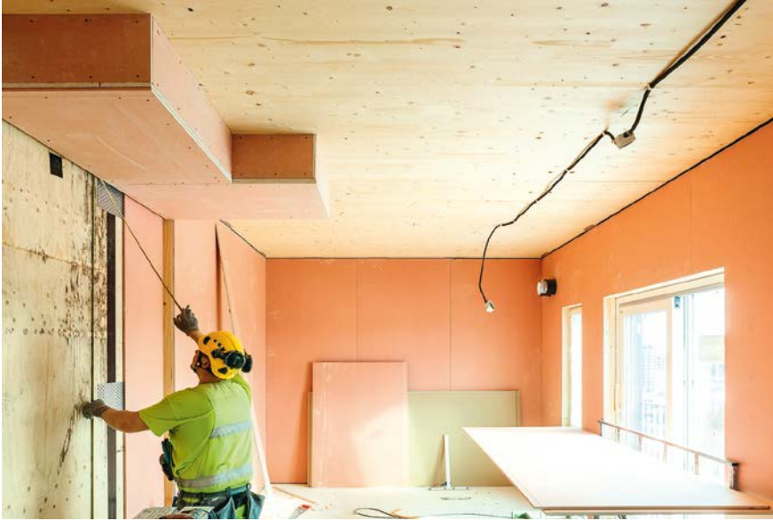
Kuva 3. Eri rakentamisen vaiheet, missä äänimittauksia tehtiin: huoneistot osin levytettyinä, läpiviennit tiivistämättä, ovet asentamatta (kuva vasemmalla), seinät levytetyt ja tiivistetty, ovet asennettu (kuva keskellä) ja asunnot valmiina ja kalustettuina (kuva oikealla). Figure 3. Sound measurements were taken at the following stages of construction: wall panels partially hung, conduits not sealed, doors not installed (figure on the left), wall panels hung, doors installed (middle figure), and the apartments finished and furnished (figure on the right).
