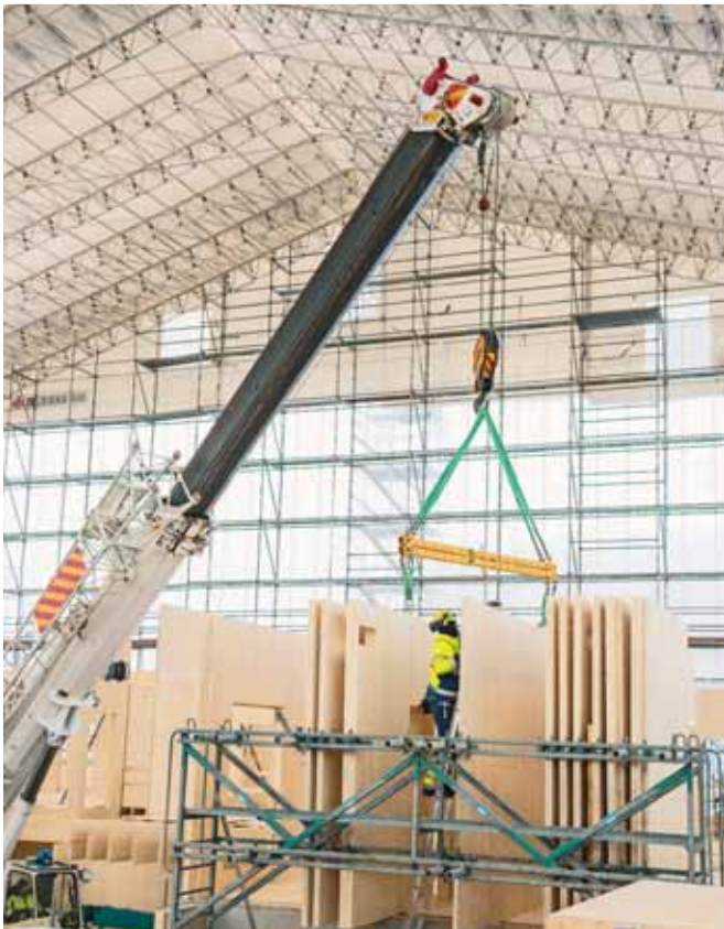
Rakennustyömaa | Construction site
