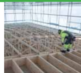
Kattoristikot: Keminmaan Puurakenne Oy
