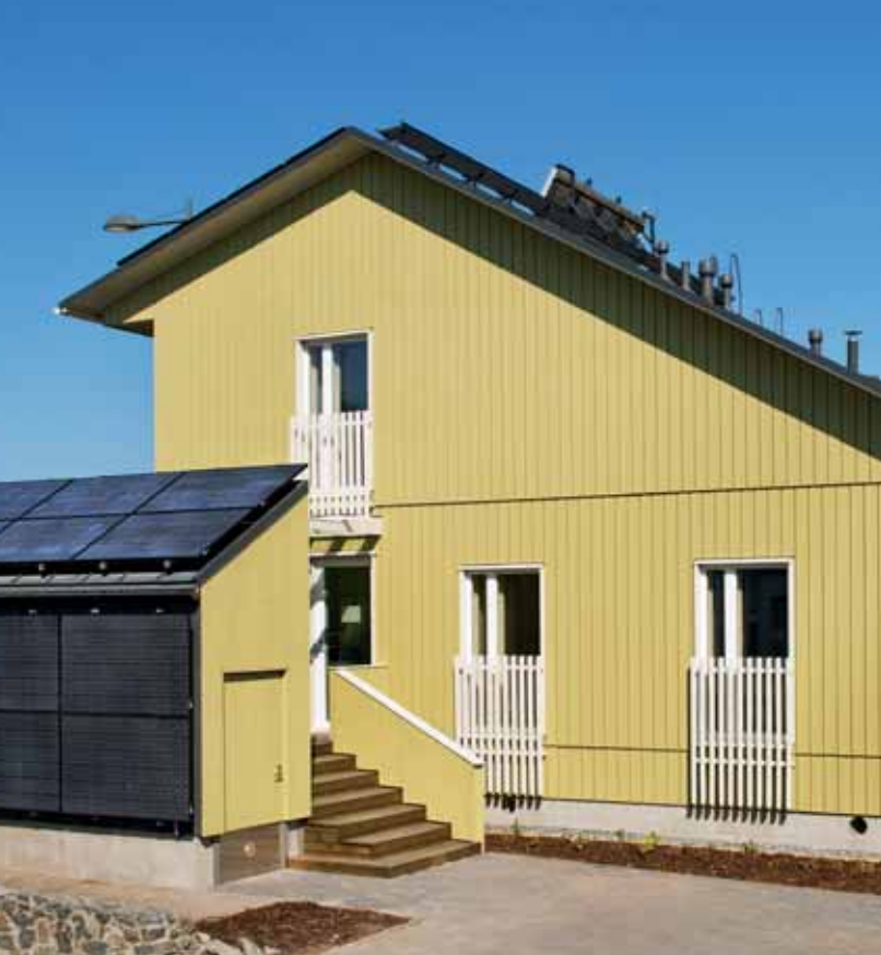
Nollaenergiatalo Lantti Tampere, 2012, suunnittelu Aalto Yliopisto. Eristetty Ekovillan hengittävillä eristeillä ja ratkaisulla.
