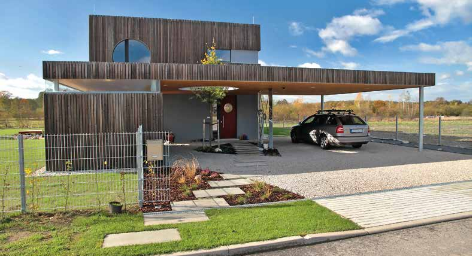
Sisäänkäynnin julkisivu ja autokatos | The entrance facade with carport
