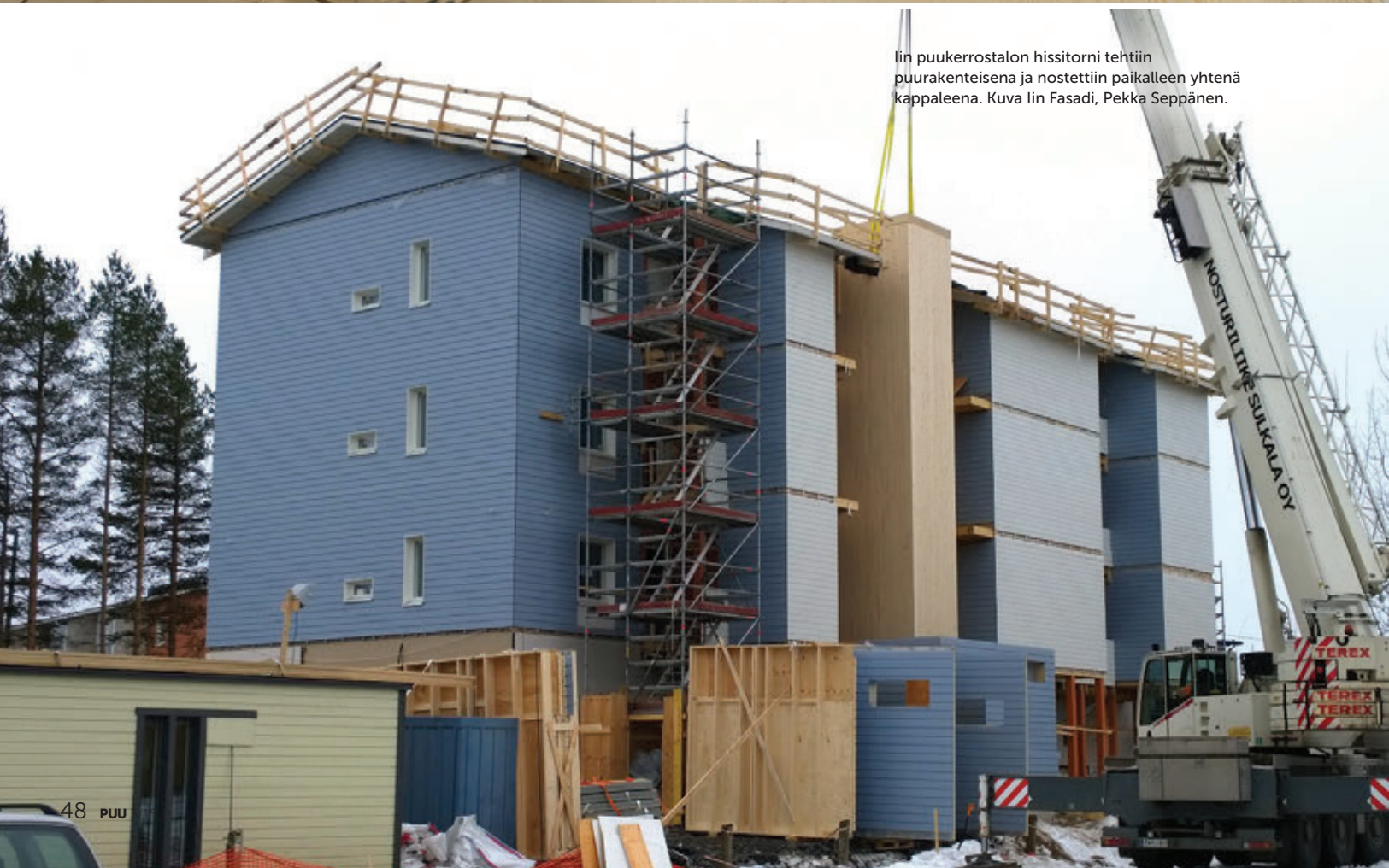
Pilaripalkki-runkoisessa rakennuksessa sääsuoja saadaan talolle nopeasti. Kuva Metsä Wood.
