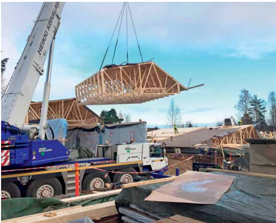
Hukanhaidan päiväkoti rakennettiin säältä suojassa. Sääsuojaus toteutettiin päälle nostettavilla kattorakenteilla ja osittain teltassa. | During construction, the Hukanhauta day-care centre was protected from the weather by means of a raised roof structure and partially with a tent.
