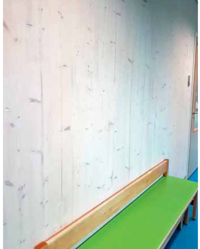
Kuva 5 Vasemmanpuoleisessa kuvassa Hukanhaidan päiväkodin 1-osaston seinäpintaa. Viereisessä kuvassa 3-osaston seinäpintaa yhdestä pahiten halkeilleesta kohdasta. 1 ja 2 osastoissa halkeilua ei juuri ollut ja seinäpinta oli lähes kauttaaltaan kuvanmukaista. | Image 5 The left-side picture shows the wall surface of section 1 of the Hukanhauta day-care centre. The adjacent picture shows the wall surface of section 3 from one of the worst cracked sites. There was no cracking in sections 1 and 2, and the wall surface was as shown in the pictures.
