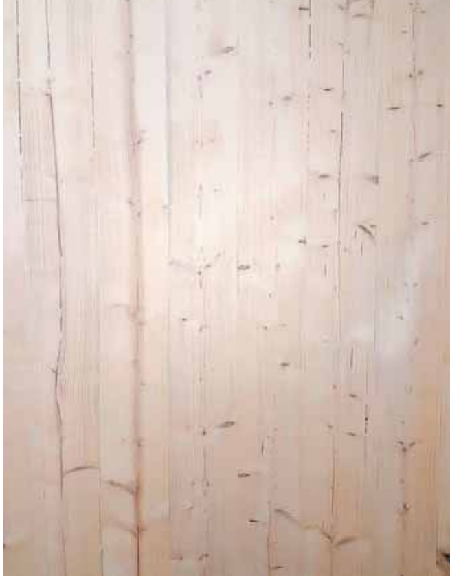
Kuva 5 Vasemmanpuoleisessa kuvassa Hukanhaidan päiväkodin 1-osaston seinäpintaa. Viereisessä kuvassa 3-osaston seinäpintaa yhdestä pahiten halkeilleesta kohdasta. 1 ja 2 osastoissa halkeilua ei juuri ollut ja seinäpinta oli lähes kauttaaltaan kuvanmukaista. | Image 5 The left-side picture shows the wall surface of section 1 of the Hukanhauta day-care centre. The adjacent picture shows the wall surface of section 3 from one of the worst cracked sites. There was no cracking in sections 1 and 2, and the wall surface was as shown in the pictures.
