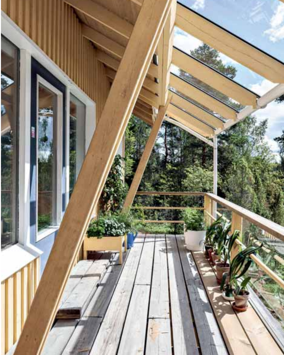
Asuntojen ilmansuunnan asemoinnilla ja kattojen lippojen suunnittelulla voidaan hyödyntää auringon säteilyenergiaa lämmityksen lisälähteenä syksystä kevääseen ja toisaalta kesällä estää asuntojen ylikuumeneminen.
