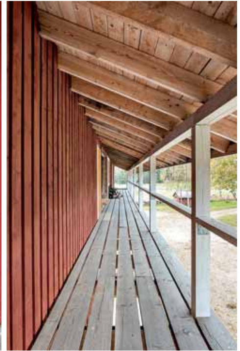
Ison aitan pitkä luhtikäytävä sopii kaikenlaiseen kuivattamiseen.
