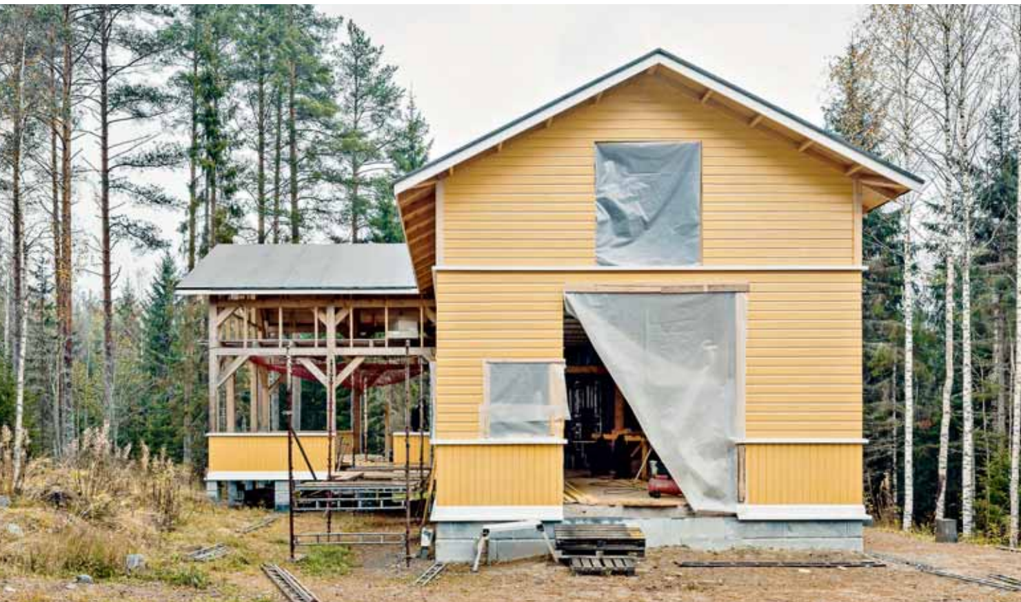
Suomen ensimmäinen aerogeelitalo on rakentumassa Kolille. Aerogeeelin ansiosta rakennuksen eristepaksuus on vain 135 mm.
