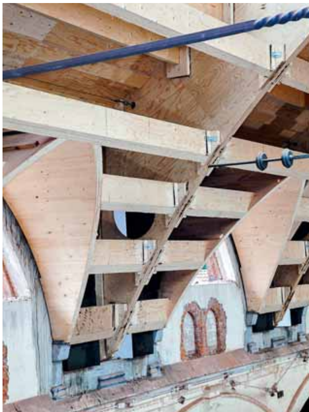
Kattorakenteita sitomaan asennettiin taotut vetotangot, joiden tehtävä on antaa rakennukselle vakautta tuulikuormia vastaan ja luoda historiallista jatkuvuutta. Tangot ovat näkyvillä kaiken aikaa, joten korrosio ei pääse yllättämään.
