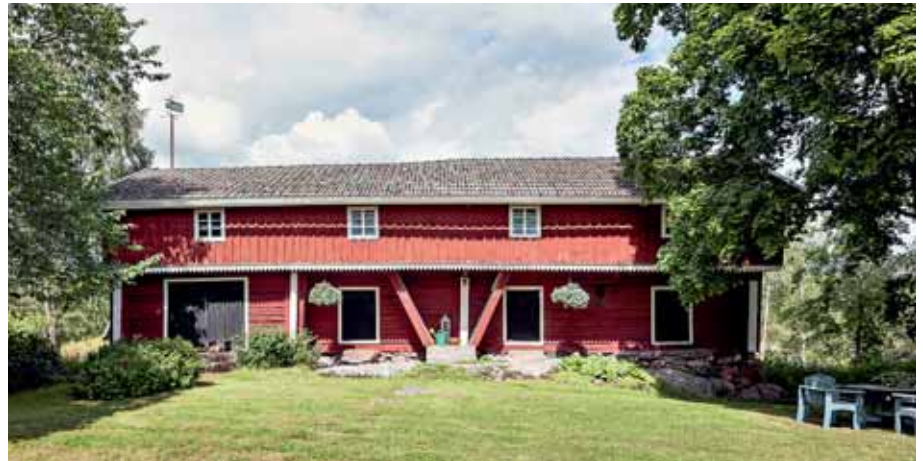
Hahkapyölin luhti on rakennettu yhdistämällä kaksi 1700-luvun pientä aittaa kolmannella välisosalla ja luhtikäytävällä noin sata vuotta sitten. Kaikki hirret, ikkunat ja ovet ovat olleet vähintään kerran aikaisemmin tilalla jossain muussa käytössä.
