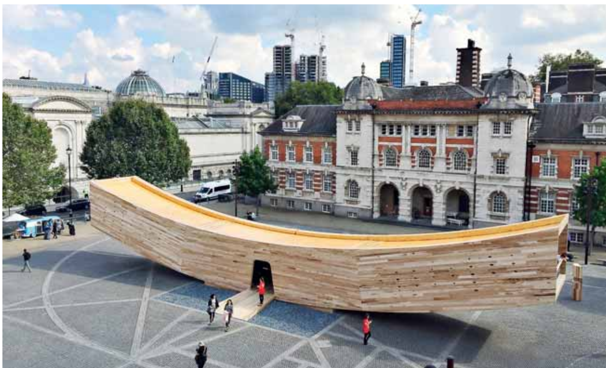
The Smile on 3,5 m korkea, 4,5 m leveä ja 34 m pitkä kaareva suorakulmainen putki. Se on tehty pohjoisamerikkalaisesta kovapuusta valmistetusta CLT-levystä. Hankkeen tarkoitus on esitellä puun käyttöä tavallisille lontoolaisille tuomalla se tutuksi keskelle kaupunkia. Samalla Smile edisti amerikkalaisen kovapuun markkinoita. Smile on suunnitellut arkkitehti Alison Brooks Arkkitehdit ja Arup. Hankkeen rahoittaa American Hardwood Export Council. Se oli näytteillä osana London Design Festivalia Chelsea College of Arts koulun paraatipihalla viime syksynä. Kuva Mikko Viljakainen
