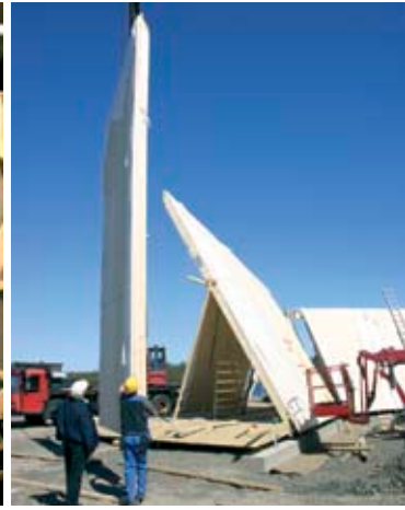
Elementtien pituus oli enimmillään 9 metriä
