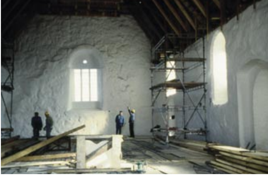
Kirkkosalin lautaholvi tehtiin lattialla ja nostettiin sektoreittain mäntyverhousta kannattamaan
