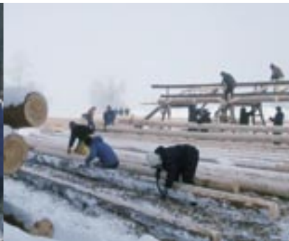
Tukkit kuorittiin ja pinnat sahattiin pois.
