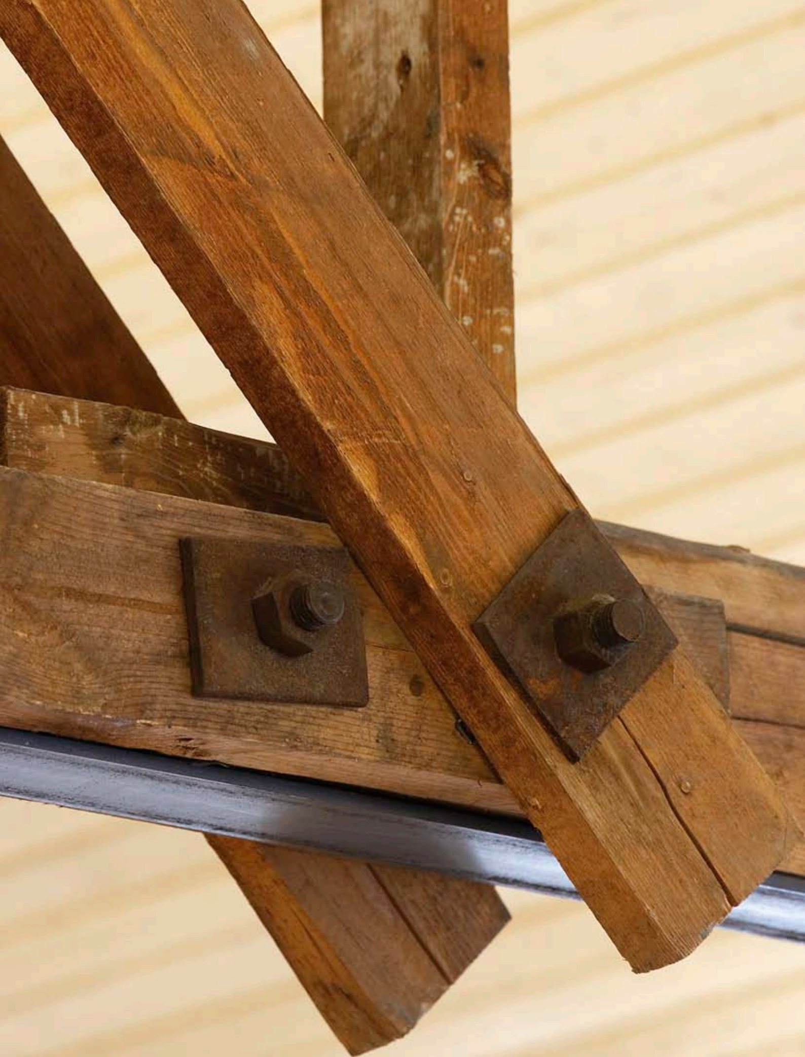
Vanhoja kattoristikkoja vahvistettiin teräsprofiililla
