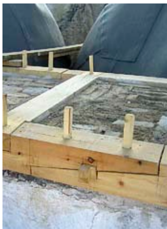
Kattorakenne toteutetaan massiivipuusta ja kootaan lovi-, pultti- sekä rengasvaarnaliitoksilla.
