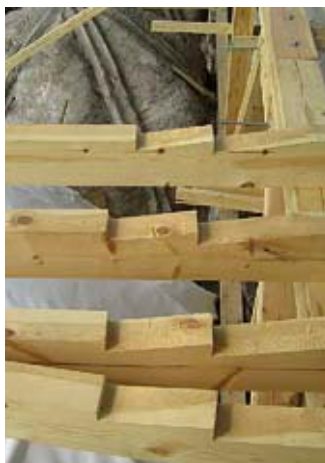
Kattorakenne toteutetaan massiivipuusta ja kootaan lovi-, pultti- sekä rengasvaarnaliitoksilla.
