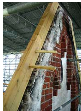
Kattorakenne toteutetaan massiivipuusta ja kootaan lovi-, pultti- sekä rengasvaarnaliitoksilla.
