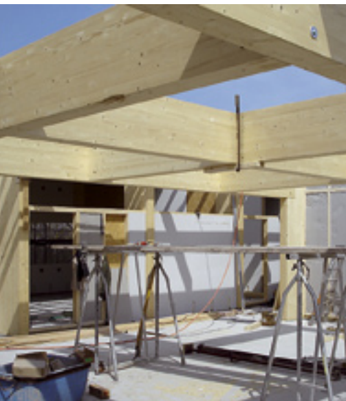
Liimapuurakenteet toimitettiin työmaalle valmiiksi työstettyinä, mikä takasi nopean asennusajan.
