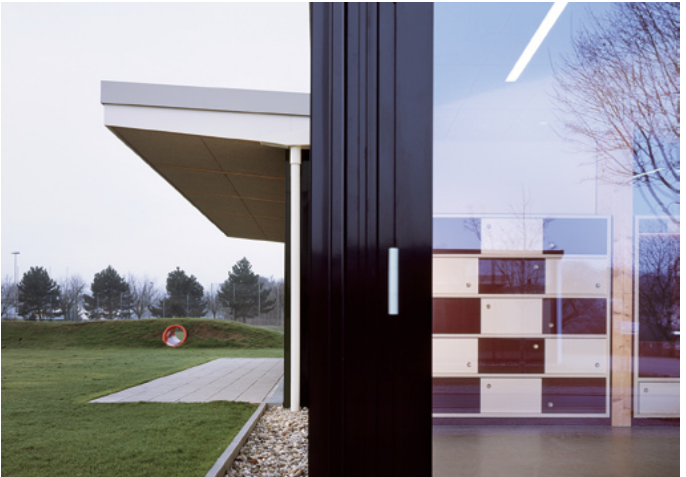
Pitkät lipat suojaavat ikkunaseiniä sekä sisätiloja liialta auringonsäteilyltä.
