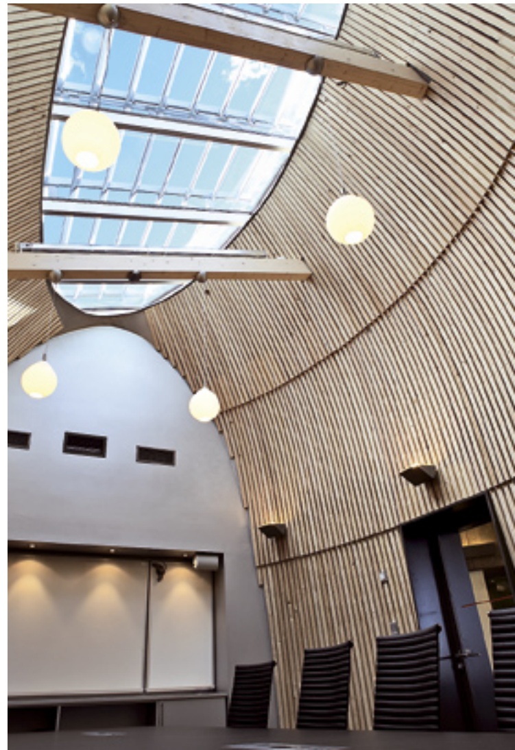
Liimapuupilarit ovat kantavana rakenteena ikkunaseinillä. Toimisto- osat ovat liimapuulevyrakenteisia. Yläkerroksen koivupintainen neuvottelutila lävistää katon ja aukeaa taivaalle.
