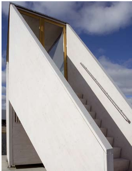
Suuret liimapuulevyt työstettiin asennusvalmiiksi ja koottiin vinoruuviliitoksien. Large timber panels were CNC crafted and fixed using diagonal screws.
