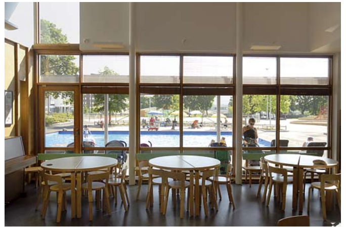
Sisäverhoukset, karmit ja kalusteet käsiteltiin puuvahoilla. Interior linings, frames, jambs and furniture are finished with wood wax.
