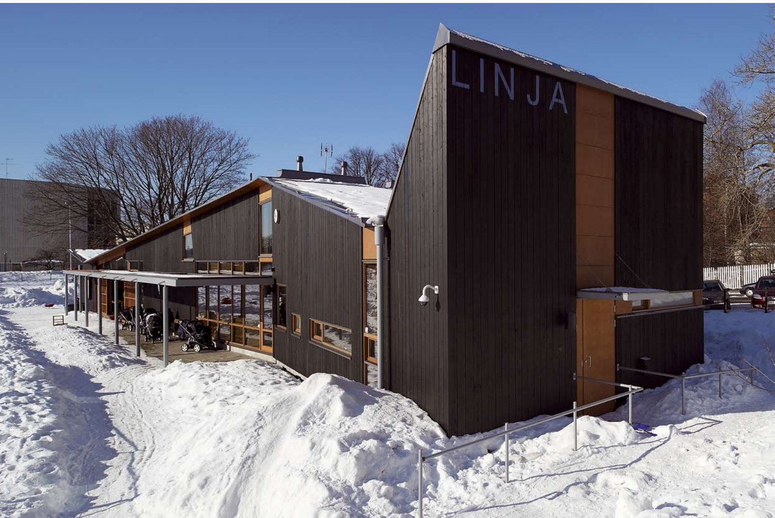
Ulkopinnat maalattiin suojaavin kuultovärein. The exterior surfaces are stained.
