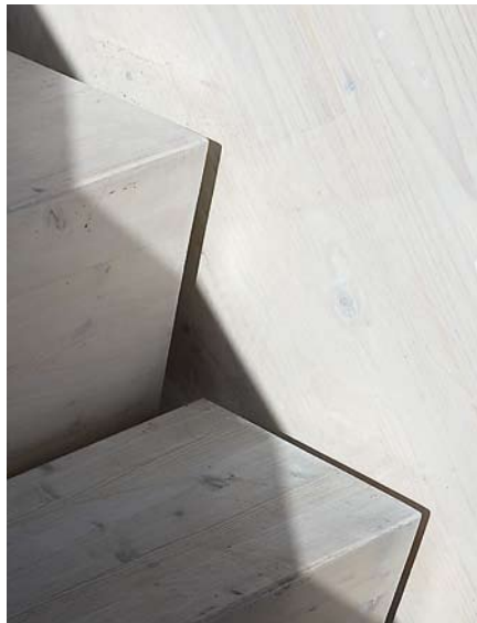
Suuret liimapuulevyt työstettiin asennusvalmiiksi ja koottiin vinoruuviliitoksien. Large timber panels were CNC crafted and fixed using diagonal screws.
