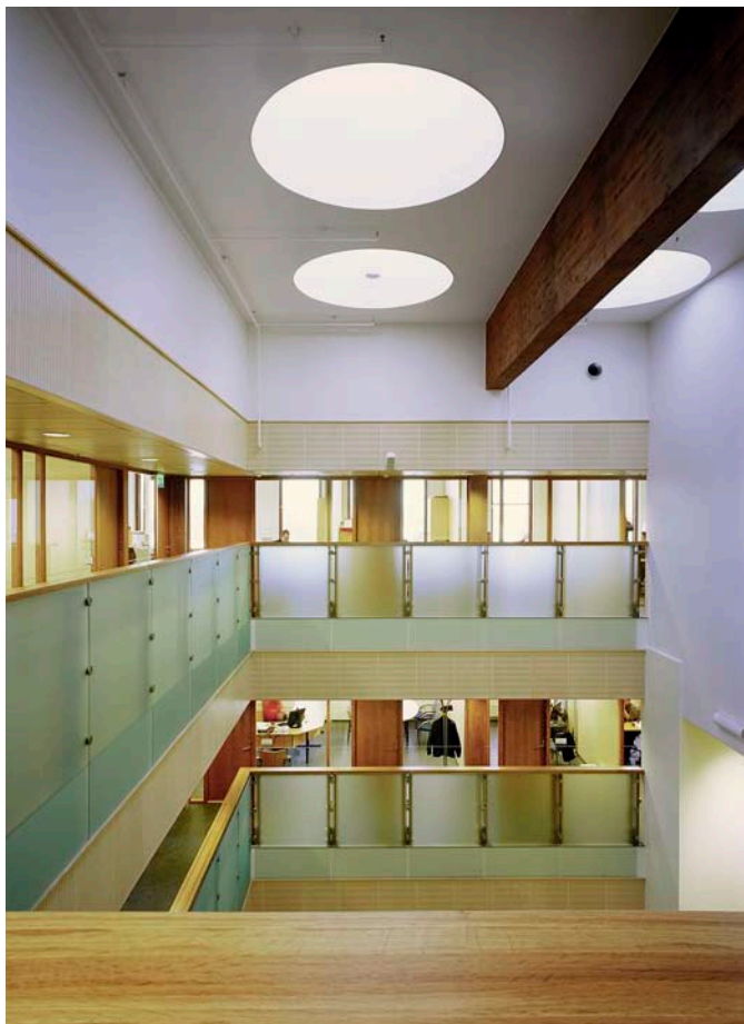
Ylimmän kerroksen avokäytävät sulkeutuvat palotilanteessa savuverholla, jolloin rakennuksesta pääsee ulos turvallisesti. In the event of fire, the open corridors on the top floor are closed with smoke curtains so that a safe exit from the building is possible.
