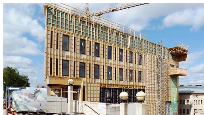
Julkisivu on koottu puisista ulkoseinäelementeistä.
