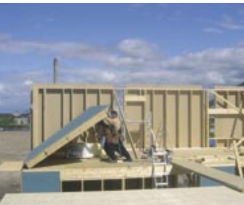
Valmis elementti nostetaan pystyyn.
