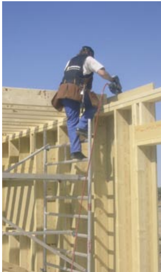
Seinäelementit tuetaan yläjuoksulla ja kehäpalkilla.
