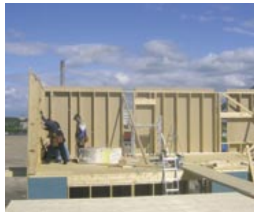
Elementti kiinnitetään alajuoksuun.
