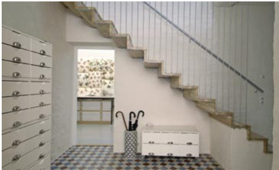
Laajennusosan seinien pinnoitteena on 2-kertainen mdf-levy, mikä mahdollistaa kiinnitykset pintojen rikkoutumatta. Vanhat tiiliseinät kalkkimaalattiin.
