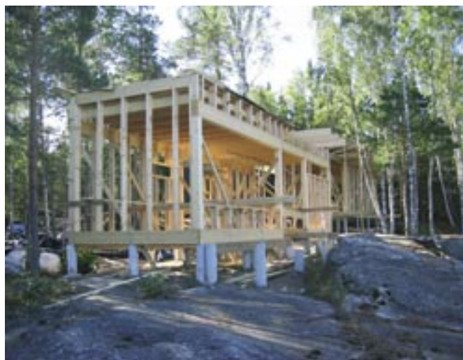
Puuosat toimitettiin pre-cut -pakettina työmaalle. Jokainen puuosa oli valmiiksi työstetty ja merkitty.
