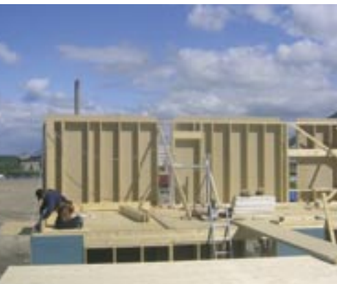
Seinäelementit kootaan valmiiksi katkottuista osista tason, platformin, päällä.
