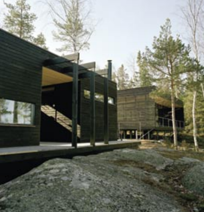
Puuosat toimitettiin pre-cut -pakettina työmaalle. Jokainen puuosa oli valmiiksi työstetty ja merkitty.
