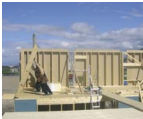
Seinäelementit kootaan valmiiksi katkottuista osista tason, platformin, päällä.
