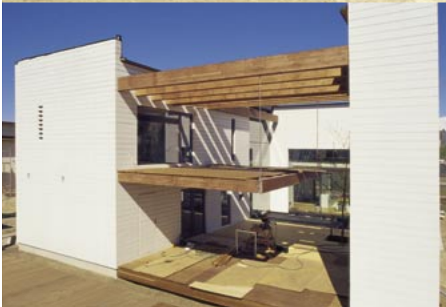
Julkisivut ovat leveää lautaa ja ulkorakenteissa kiinnittävät huomiota jyhkeät puupalkit.
