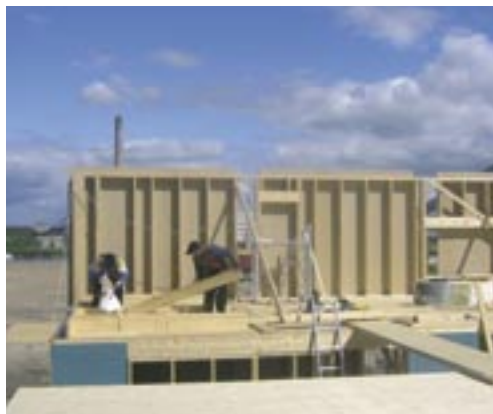
Seinäelementit kootaan valmiiksi katkottuista osista tason, platformin, päällä.
