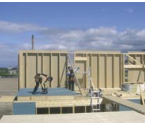
25 mm:n tuulensuojalevy jäykistää elementin.
