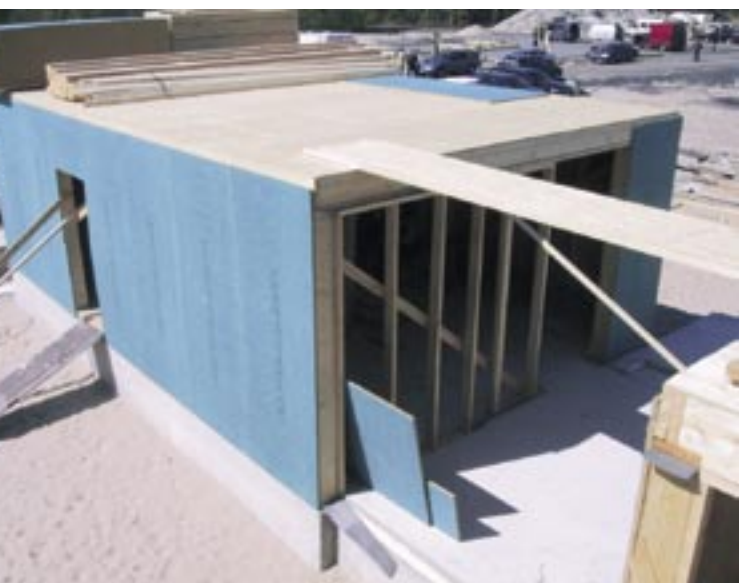
Valmis elementti nostetaan pystyyn.
