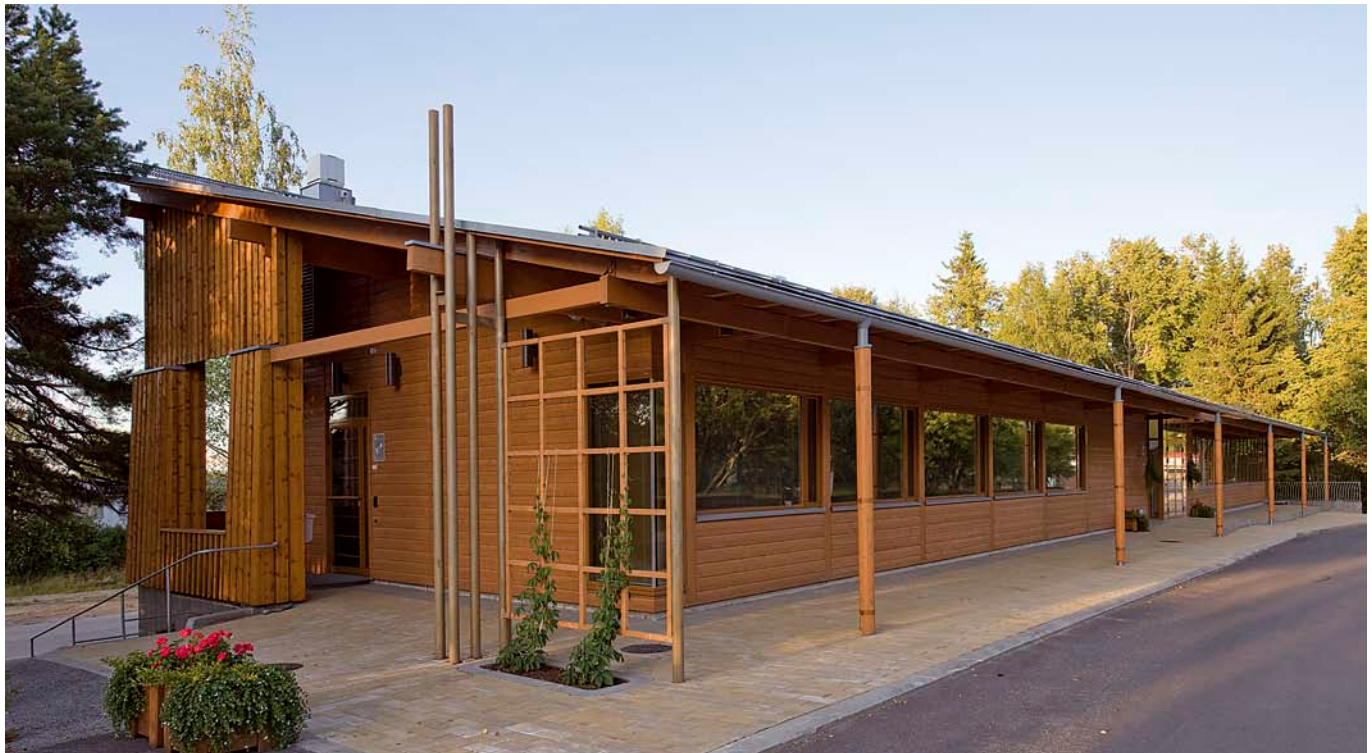
Tervamaalattu verhoaus on paksua, hienosahattua kuusilautaa. The tar-painted cladding is in thick, fine-sawn spruce boarding.
