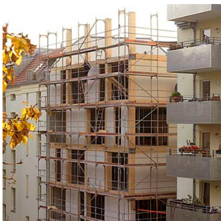
Esivalmistetuista osista koottu talo nousi kerroksen viikossa. Prefabricated components enabled a schedule of one week per storey.
