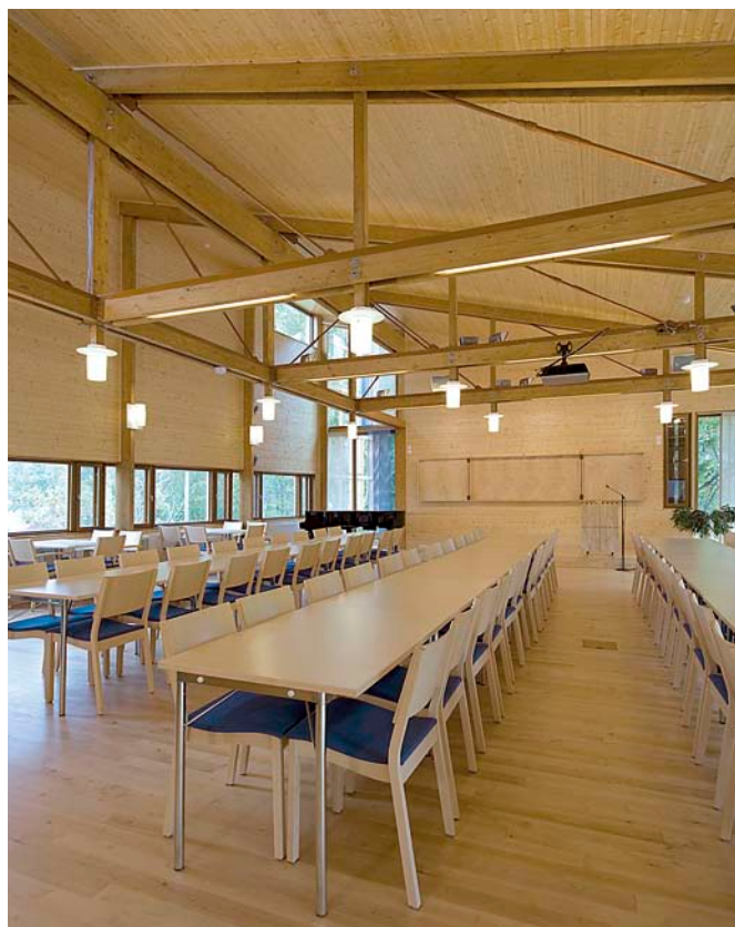
Sisäpinnat ovat höylättyä 27 mm kuusilautaa. Liimapuupilarit ja puuristikot jäsentävät sisätilaa.
