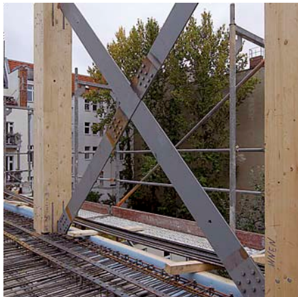
Välipohjissa on liimapuulevy-betonirakenne ja ulkoseinät ovat ristiin liimattua puulevyä. Intermediate floors have a cross-laminated timber-concrete slab. The outer walls are in cross-laminated timber.
