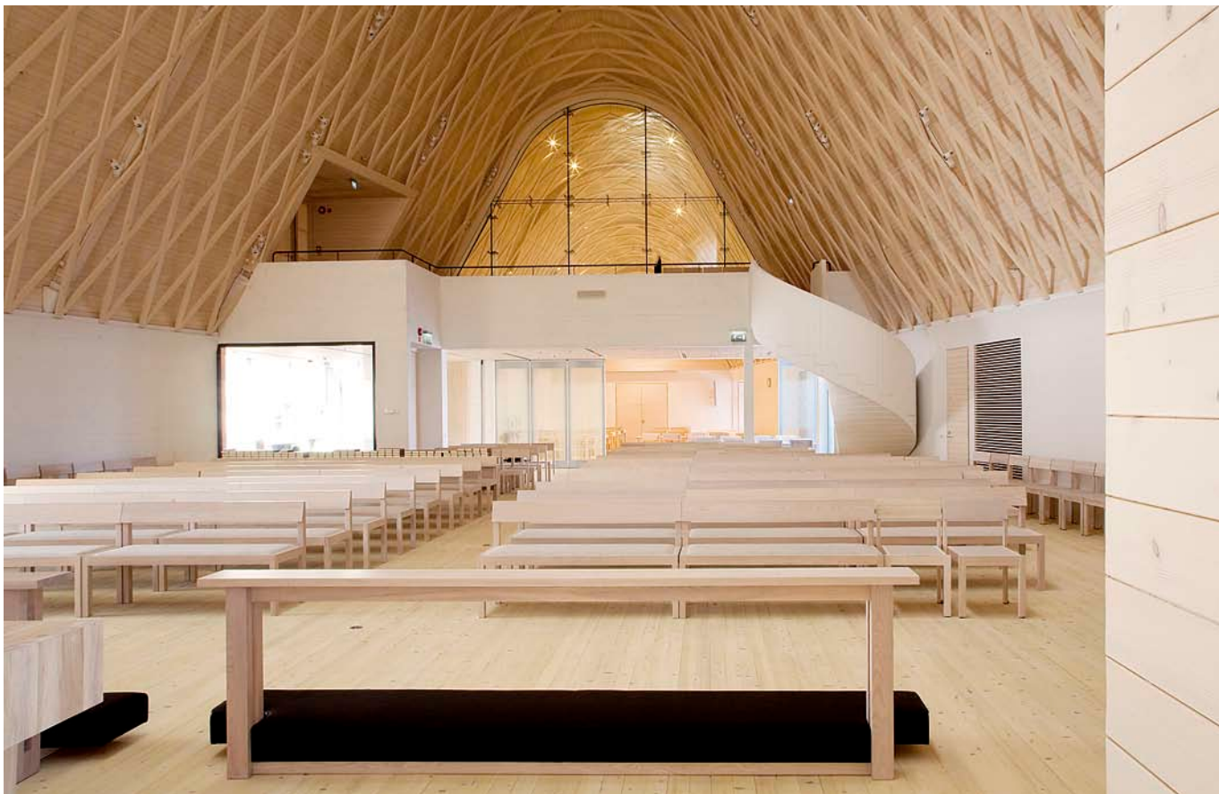
Katon muodon määrittelee 13 ristikkorakenteista liimapuukehää, jotka kannattavat kirkon liuskekivikuorta. The form is determined by the 13 laminated timber frames, which support the slate cladding.
