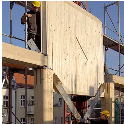
Välipohjissa on liimapuulevy-betonirakenne ja ulkoseinät ovat ristiin liimattua puulevyä. Intermediate floors have a cross-laminated timber-concrete slab. The outer walls are in cross-laminated timber.
