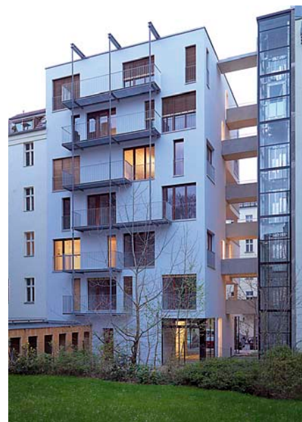
Hissi- ja porrastorni on sijoitettu erilleen puurunkoisesta asunto-osasta. Asuntoihin pääsee betonisiltoja pitkin, tilavan terassin kautta. Access to the floors is via a free-standing concrete staircase. A terrace in front of the apartments opens towards the street.
