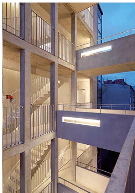
Hissi- ja porrastorni on sijoitettu erilleen puurunkoisesta asunto-osasta. Asuntoihin pääsee betonisiltoja pitkin, tilavan terassin kautta. Access to the floors is via a free-standing concrete staircase. A terrace in front of the apartments opens towards the street.
