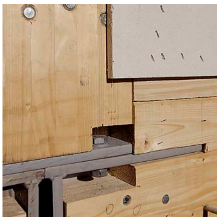
Pilarien ja palkkien liittymiä varten kehitettiin kolme teräksistä liitostyyppiä. Three steel joints were specially developed for the timber frame.
