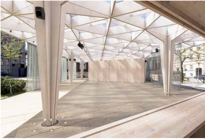
Terassitaso on tehty mäntyliimalevy-lankuista. Kahvila ja ohjelmatila ovat mäntyliimalevyelementeistä koottuja. The terrace floor has a covering of laminated pine elements. The café and media space are assembled from laminated pine elements.
