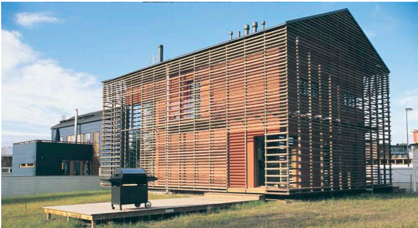
Puutalokortteliin rakennetun kivitalon ympärille rakennettiin kattotuoleista ripustettu puuhuntu.
