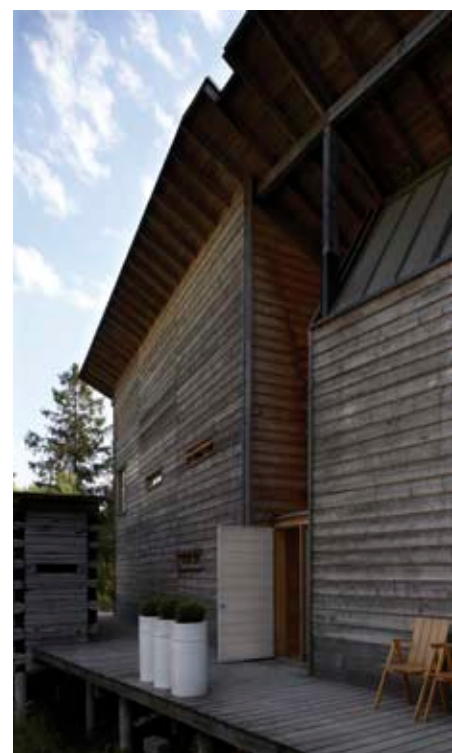
Ulkoseinät on verhottu kuusilankuin ja ulkotasot ovat lehtikuusta.
