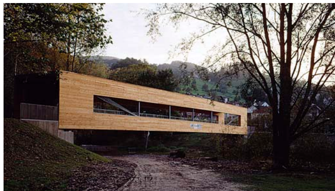
Silta, Gaißau 1999 Bridge, Gaißau 1999
