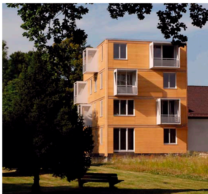
Vuonna 2010 rakennettu puukerrostalo Saksan Mietrachingissa on yksi koekohteista hiilijalanjäljen tarkkaan laskentaan. Arkkitehti: Schankulla. This wooden apartment building built in 2010 at Mietraching in Germany is one of the test buildings used for accurate calculation of carbon footprints. Architect: Schankulla.
