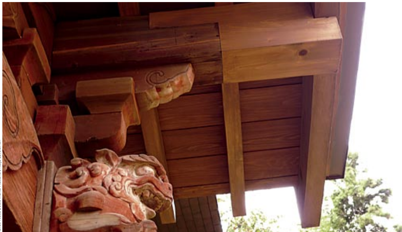
Tozenjin vanhan temppelin julkisivuvärjäystä ja restauroitaessa pidennetty räystääs.
