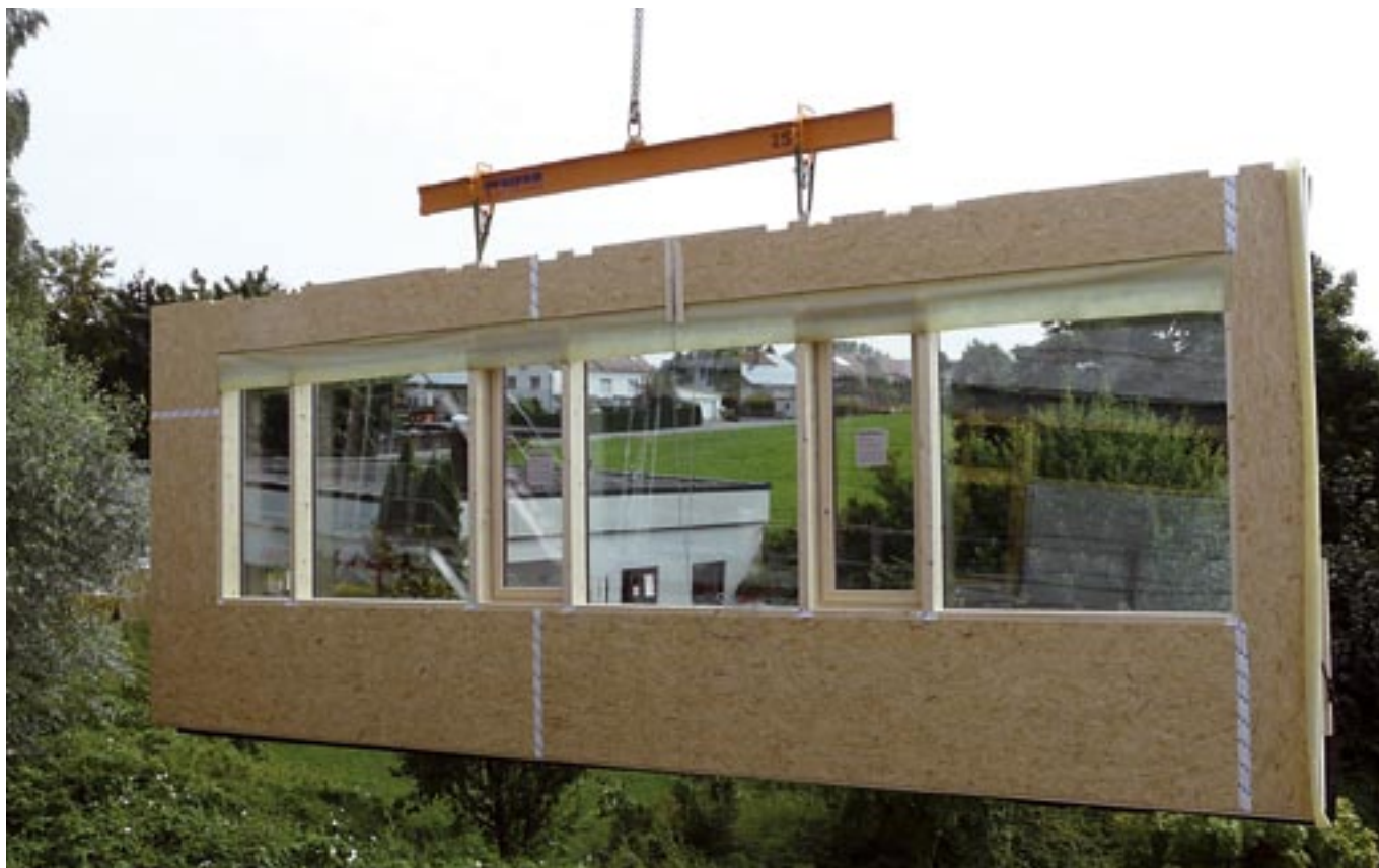
TES elementit ovat puurunkoisia suurelementtejä. Asennus tarvittaessa ilman rakennustelineitä. Buchloe koulun korjaustyömaa.
