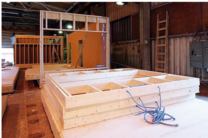
Päiväkoti koottiin kuudestatoista tilaelementistä.
