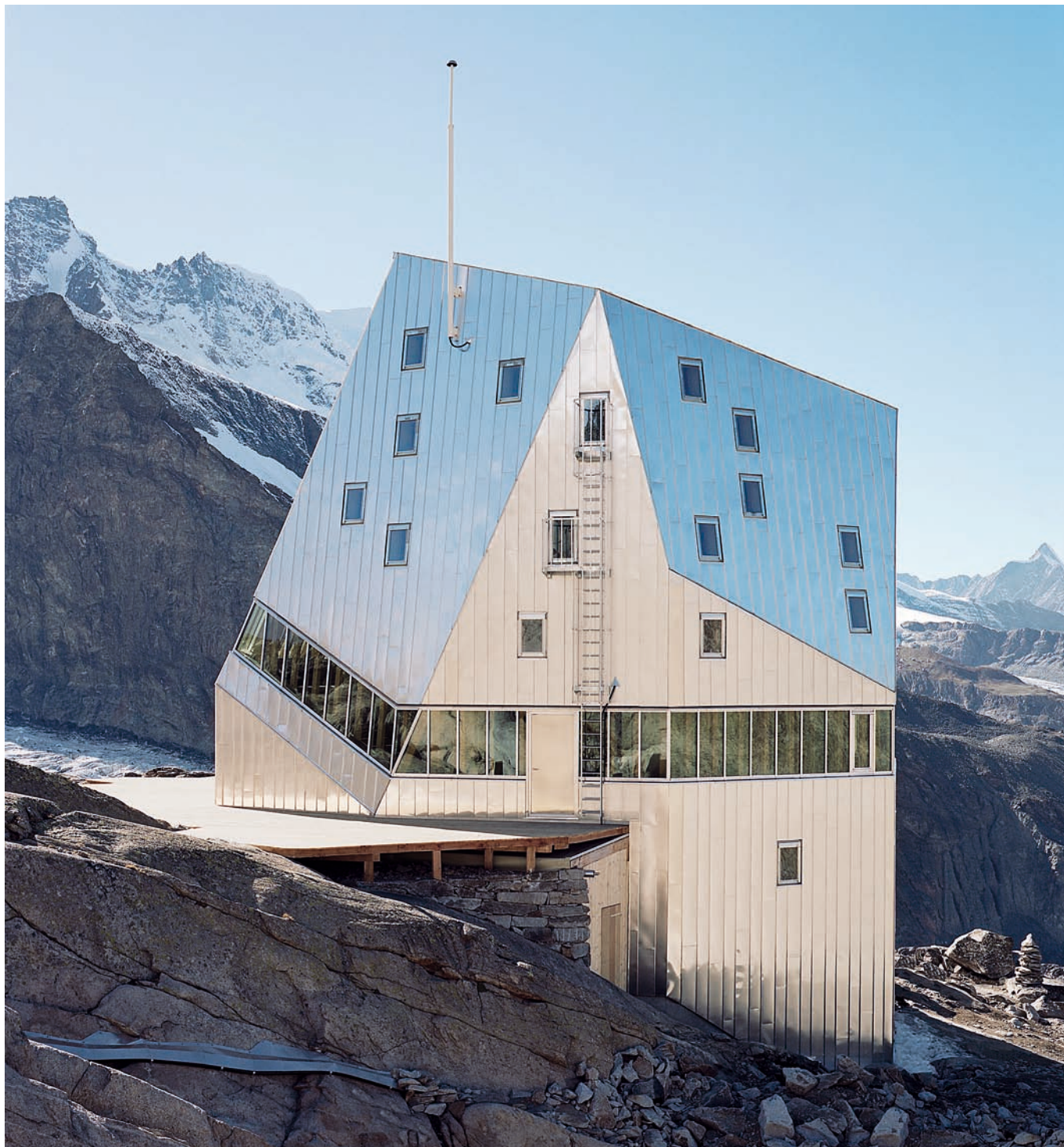
Alumiinikaseteilla verhottu maja on nimetty Vuoristokristalliksi. Kristallimaisen muodon tavoitteena on mahdollisimman pieni ulkoseinän määrä. Aluminium panel-clad Hut has been named Mountain crystal. The idea of the shape is to present the smallest possible amount of external wall.
