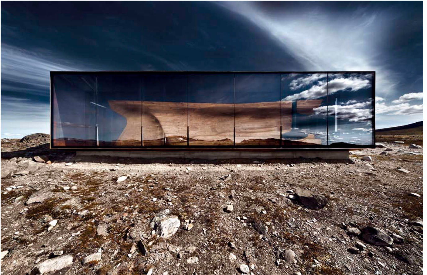
Laatikkomainen kehys on ruostuvaa, mustaa terästä. Sisäosa on 250 x 250 millimetrin kokoisista mäntyhirsistä työstettyä massiivista puuta. The box-like frame surrounding the window wall is of raw steel. The interior is worked from solid pine logs.
