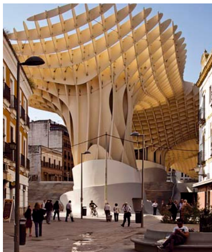
Perustukset, sylinterinmuotoiset hissikuilut ja arkeologisen museon yläpuolinen toritaso on tehty betonista.
