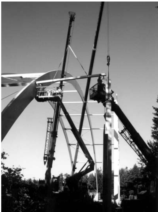
Kuva 9.5 Kaarirunkoinen urheiluhalli asentamisen käynnissä.
