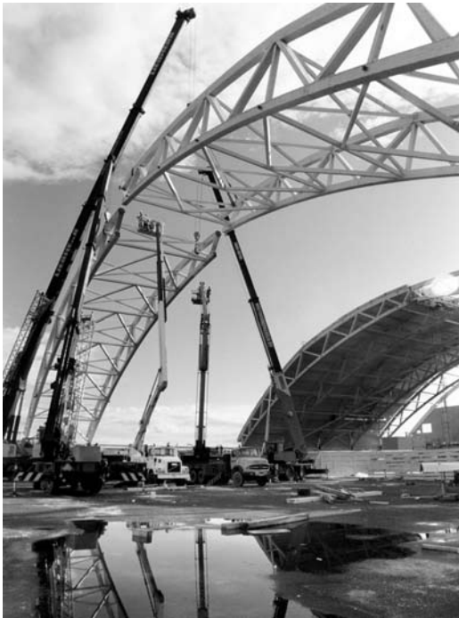
Kuva 3.10 Ristikkokaarien asentaminen käynnissä.
