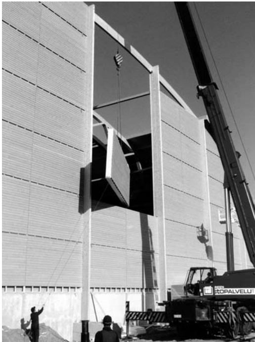
Kuva 7.1 Seinäelementin asennus
