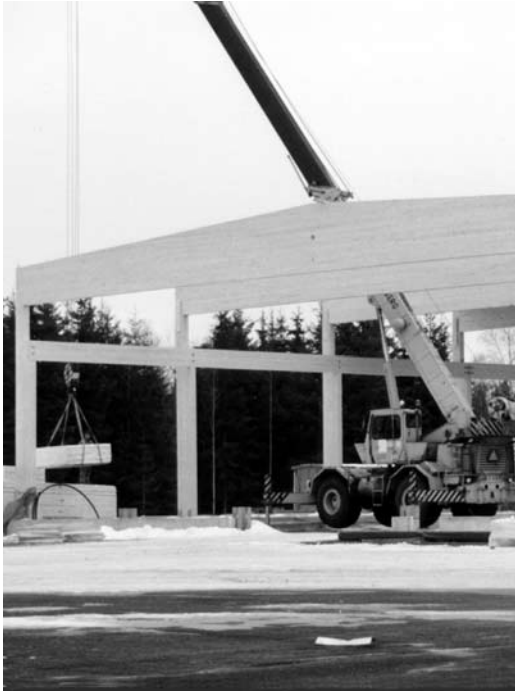
Kuva 9.1 Pilari-palkkirunkoisen varastohallin asennus käynnissä.
