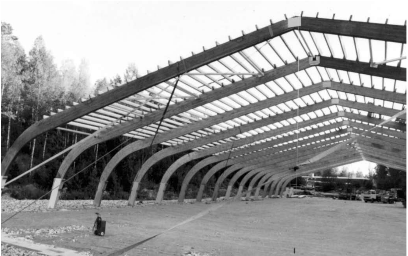
Kuva 3.12 Kehärunkoinen maneesi rakennusvaiheessa.
