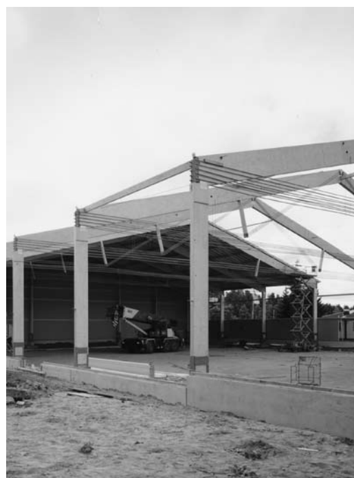
Kuva 3.8 Vetotankokannattajat asennettuna varastohalliin.
