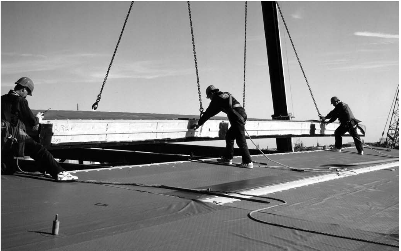
Kuva 7.7 Hartwall-areenan kattoelementtien asentamista
