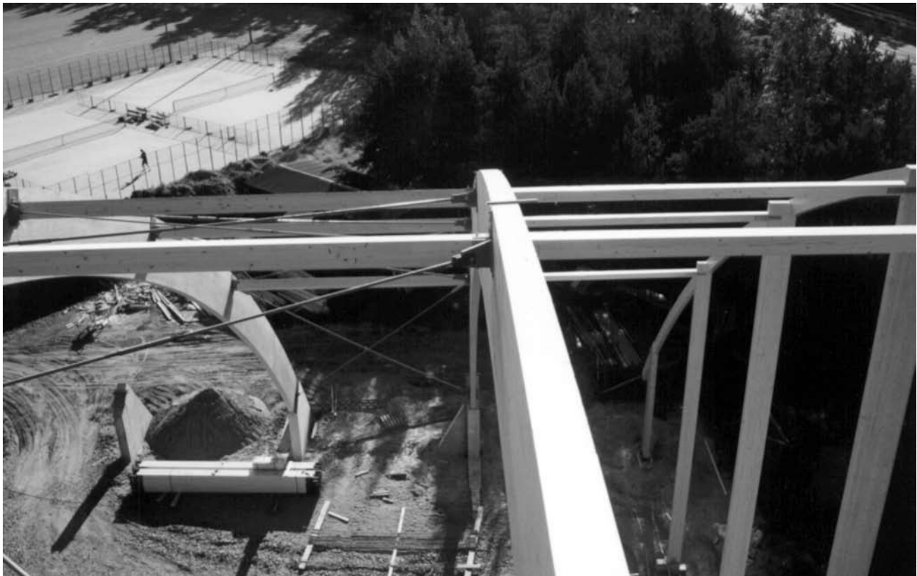
Kuva 6.8 Kaarihallin katon tuuliristikon asennus käynnissä
