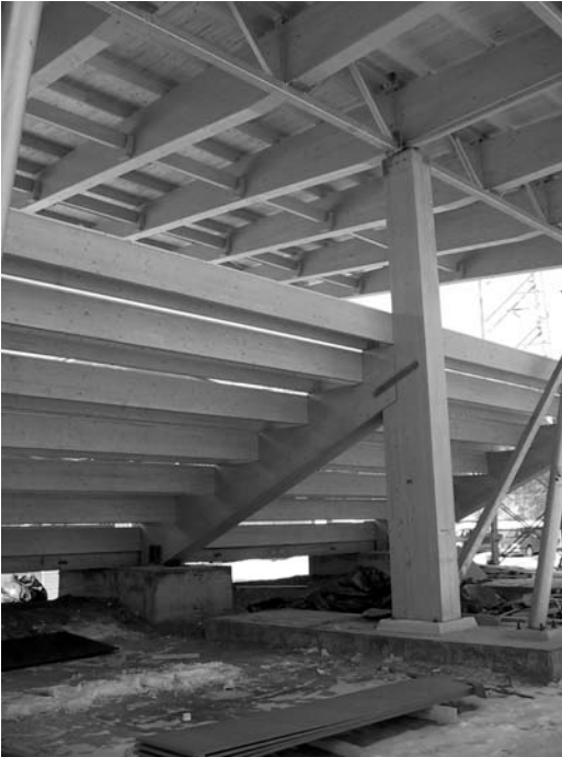
Kuva 5.1 Katsomorakenteiden liittyminen perustuksiin.
