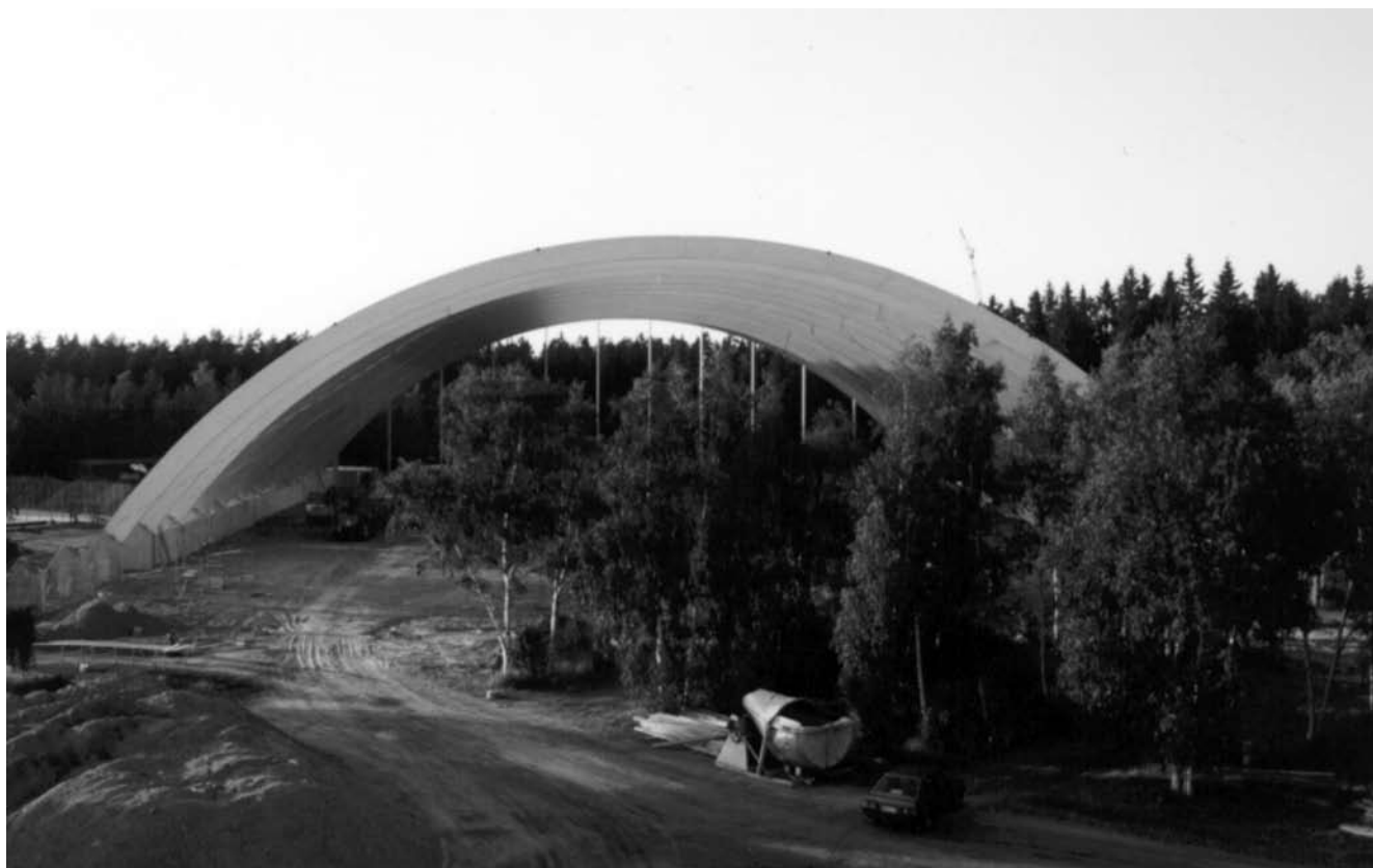
Kuva 1.1 Puuta puiden keskellä, kaarihallin asennus käynnissä
