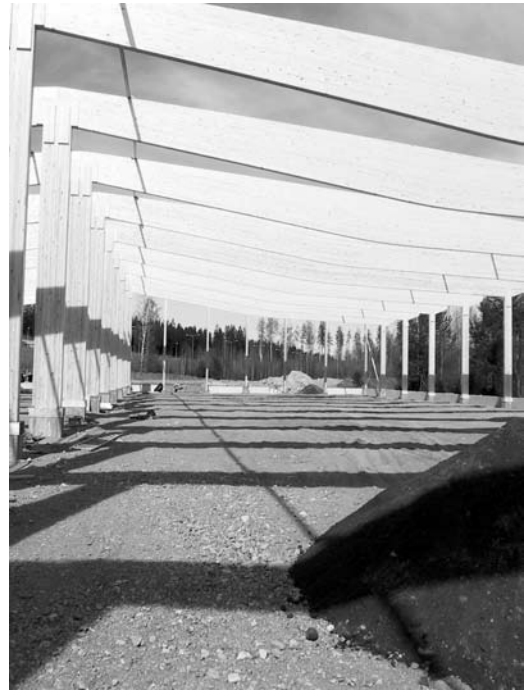
Kuva 2.4 Käännetyt harjapalkit eli ns. mahapalkit varastohalliratkaisussa.
