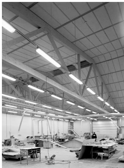
Kuva 2.6 Tehdastilan kattoristikko ja kattoelementit asennettuna.
