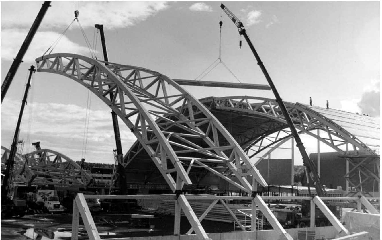
Kuva 6.16 Pirkkahallin rungon ja katon asennus käynnissä
