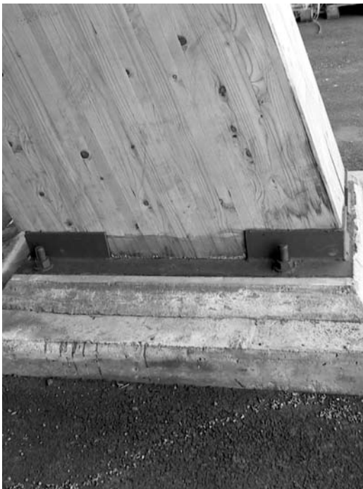
Kuva 3.2 Rungon jäykkä liitos perustuksiin.
