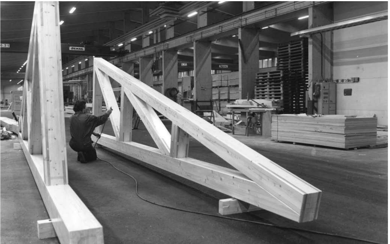
Kuva 2.2 Ristikkorakenteen viimeistelyä tehtaalla.
