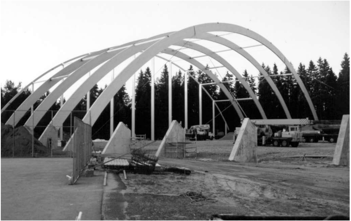
Kuva 3.9 Kaarirunkoisen urheiluhallin asennus käynnissä.
