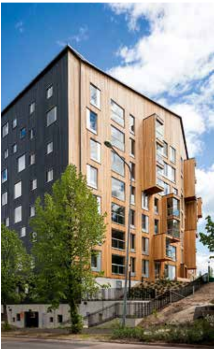
Kuva 9. Puurunkoinen asuinkerrostalo, jossa on kahdeksan kerrosta ja pääasiallisesti maan alla oleva kellari.
