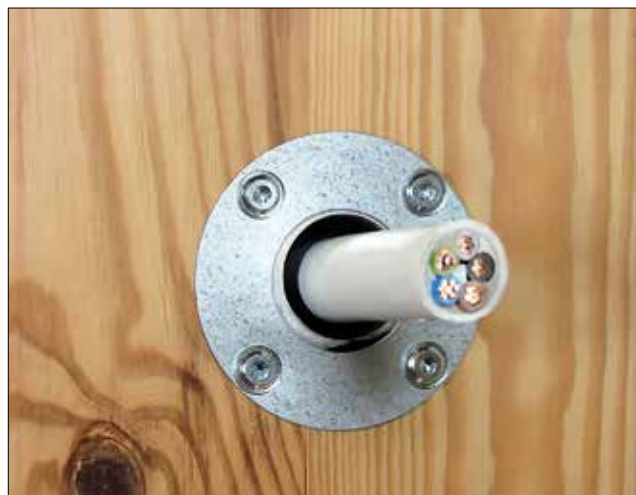
Kuva 50. Kaapeliläpivienti puurakenteessa. Kuva: Sewatek
