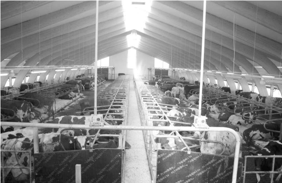
Kuva 22. Tuotantorakennuksessa painovoimainen ilmanvaihto (Kuva Jouni Pitkäranta)
