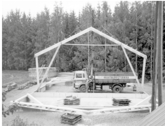
Kuva 51. Kolminivelkehä järeästä sahatavarasta
