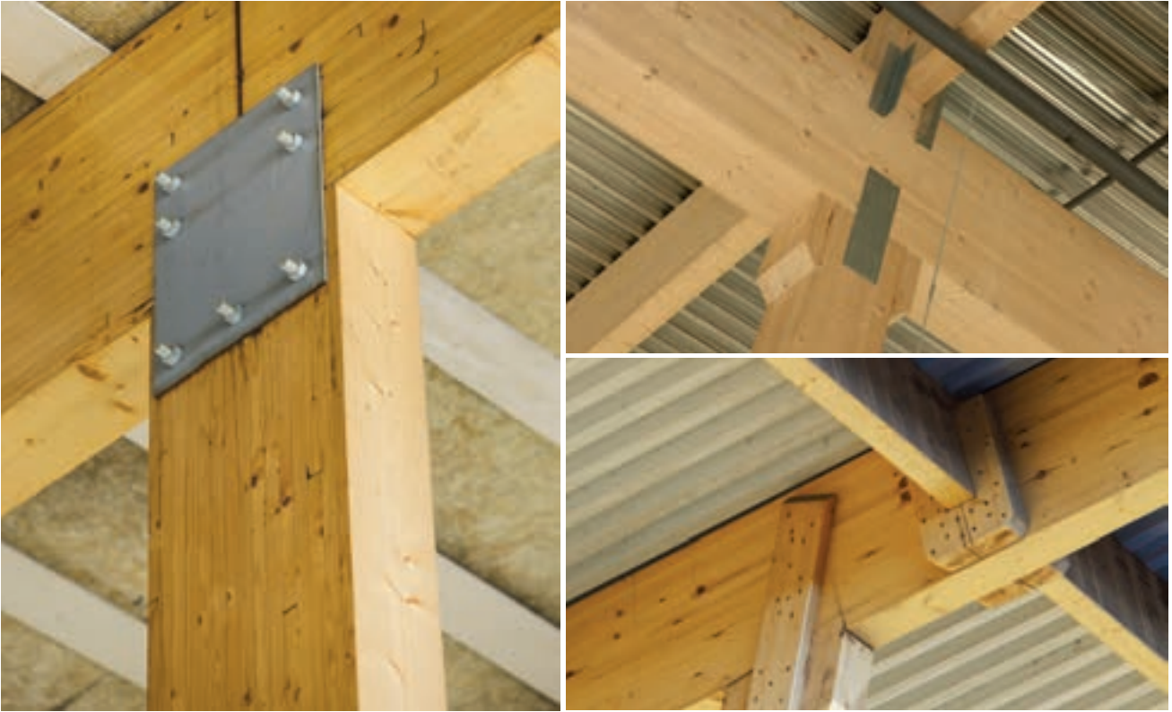
KUVA 88 Liitosten muotoilulla on suuri vaikutus ulkonäköön. (Sören Håkanlind ja Ladec, Loma Graphics Oy).
