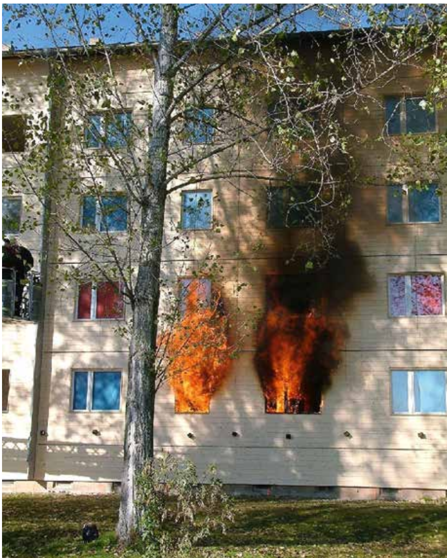
Kuva 2. Ikkunasta ulos tulevat liekit yltävät helposti yläpuolella olevan asunnon ikkunaan. Kuva: Pekka Nurro
