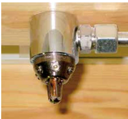
Kuva 65. Korkeapainevesisumujärjestelmän suutin pinta-asennettuna asuinkerrostalon kattoon. Kuva: Versowood
