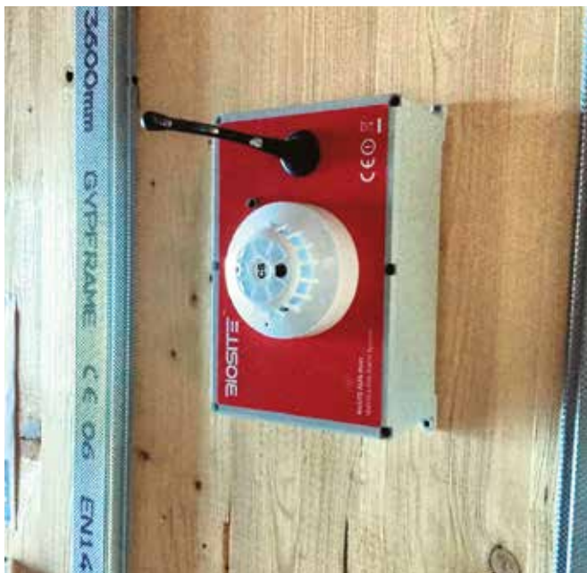
Kuva 58. Rakennustyömaalla käytössä oleva langaton palovaroitinjärjestelmä.
