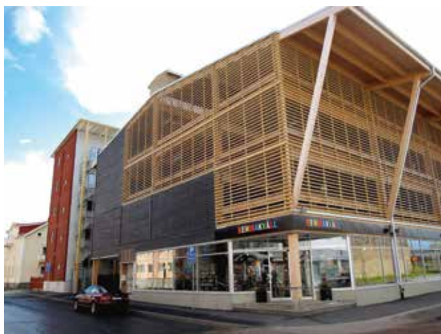
Kuva 17. Esimerkki puurakenteisen pysäköintitalon ritiläjulkisivusta Ruotsissa Skellefteåssa.
