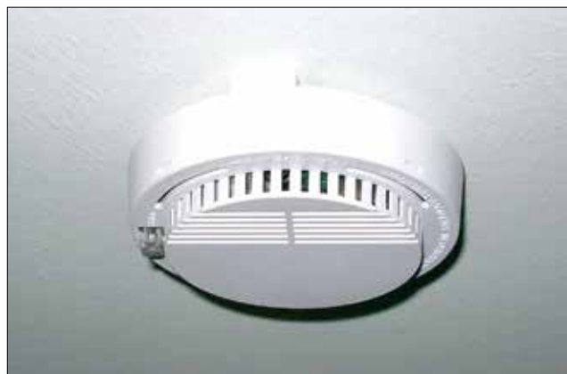
Kuva 57. Sisätiloihin tarkoitettu palovaroin. Kuva: SPEK
