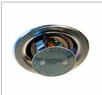
Kuva 64. Matalapainesumusuutin asennettuna. Kuva: Enexia
