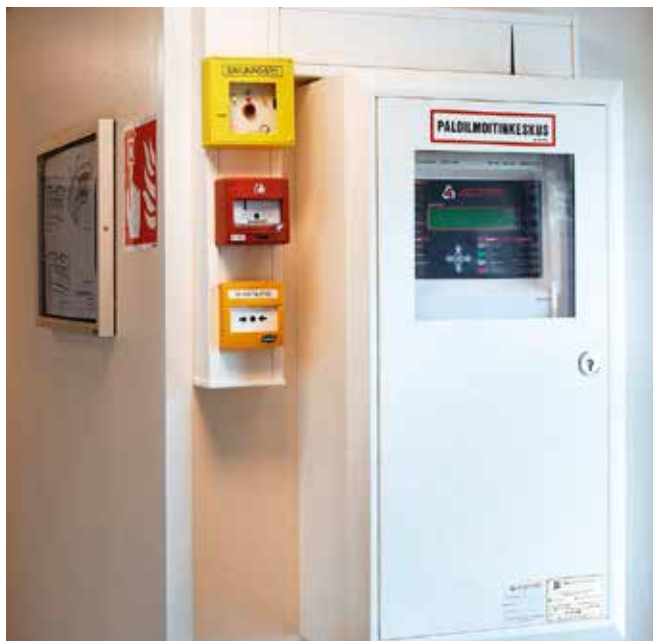
Kuva 59. Asuinkerrostalon paloilmointikeskus.
