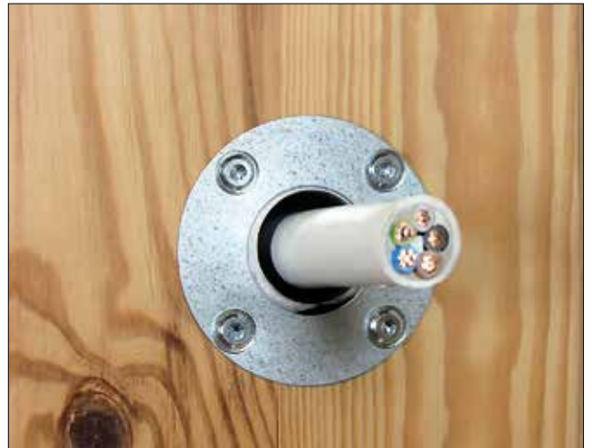
Kuva 50. Kaapeliläpivienti puurakenteessa. Kuva: Sewatek
