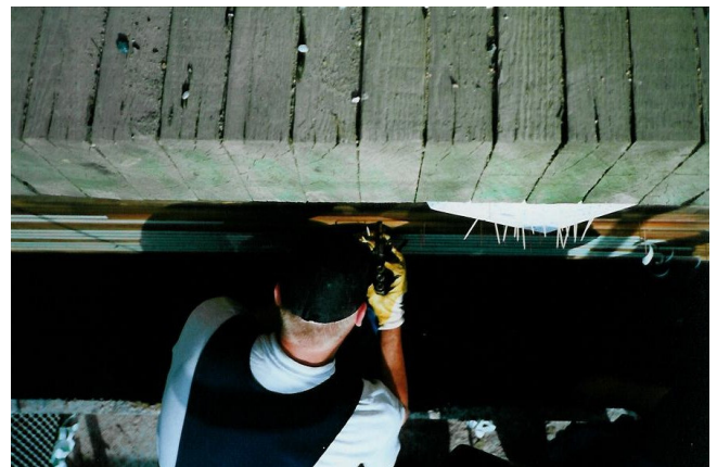
Kuva 4. Injektointia erikoissuutinta käyttäen.
