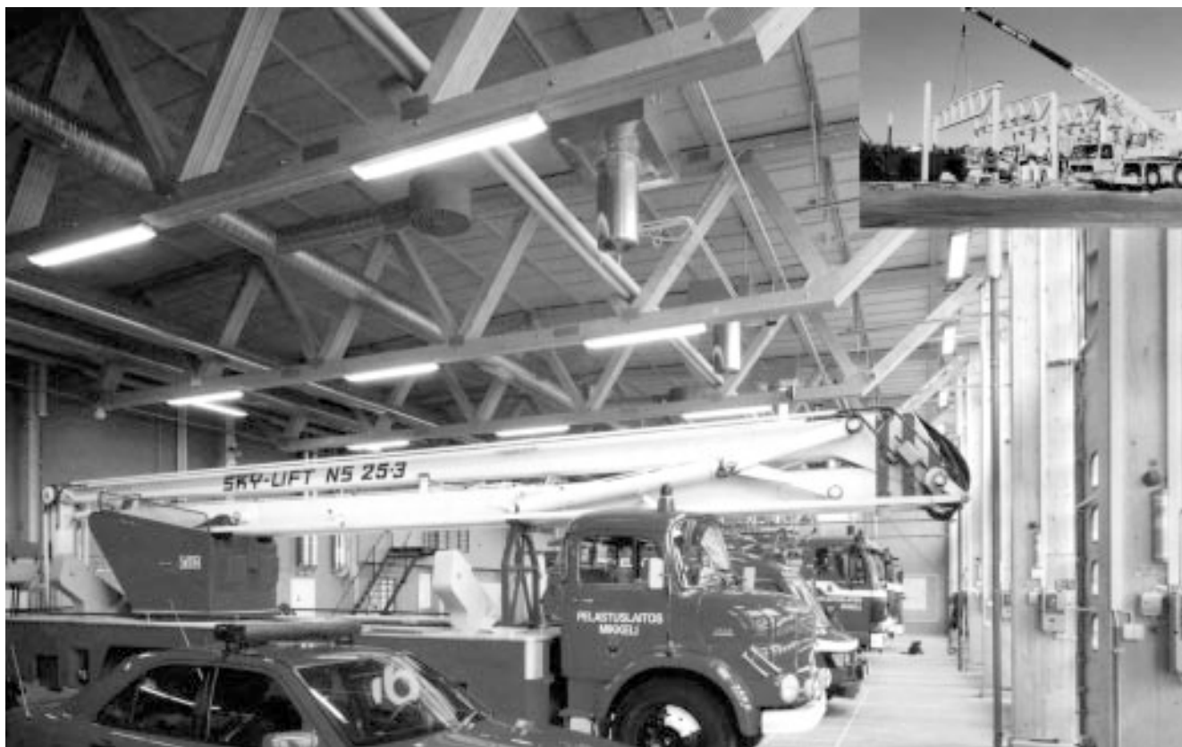
Kuva 3.22 Ristikkorakenteiset yläpohjat sopivat myös jänneväleiltään suurempiin kohteisiin. Kuvassa on Mikkelin paloasema.
