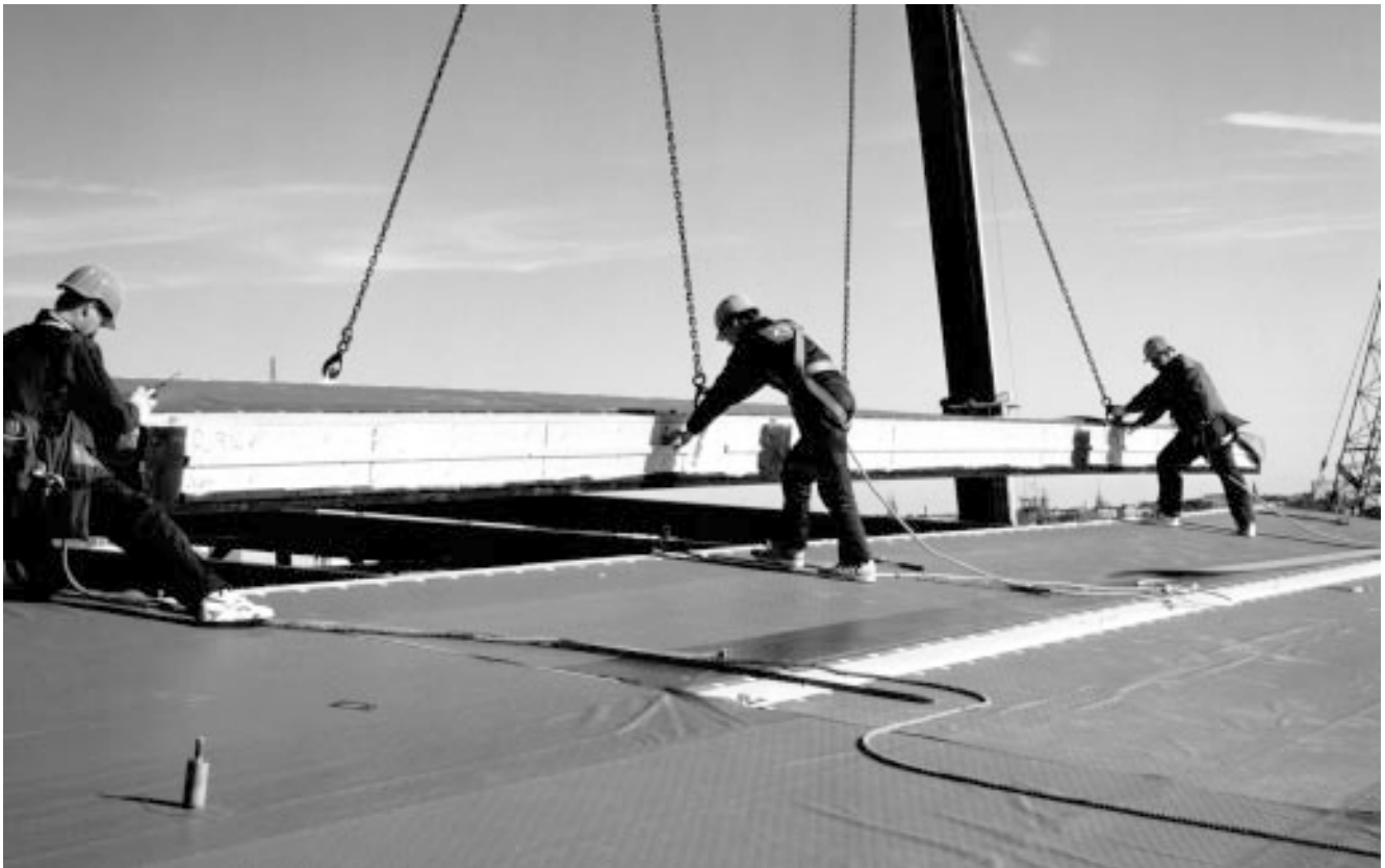
Kuva 3.5 Kattoelementtien asennus käynnissä.
