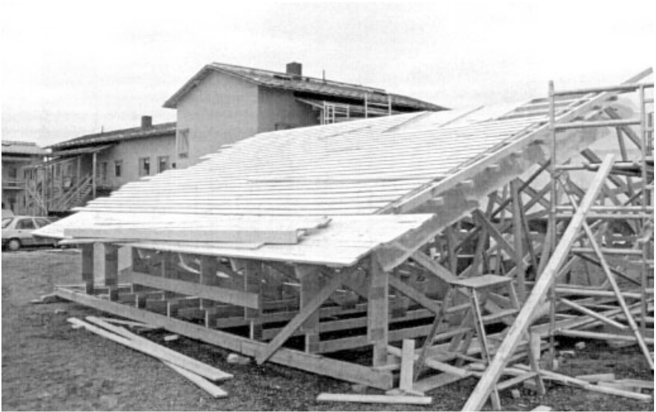
Kuva 3.21 Naulalevyristikoista voidaan työmaalla koota esivalmisteisia kattolohkoja, jotka nostetaan katolle.
