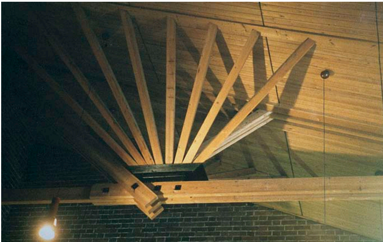
Kuva 9.1 Säynätsalon kunnantalon kattorakenteen liitoksia.
