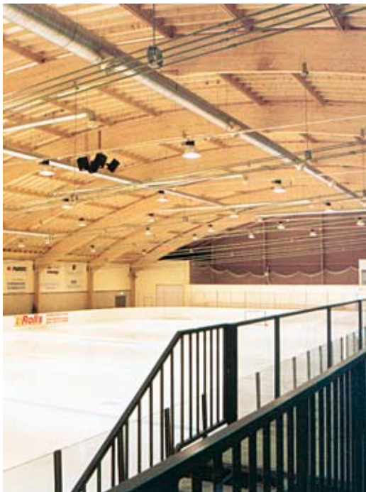
Kuva 2.18 Vetotangolliset kaaripalkit muodostavat jäähalliin ilmavan sisätilan. Kangasalan jäähalli.
