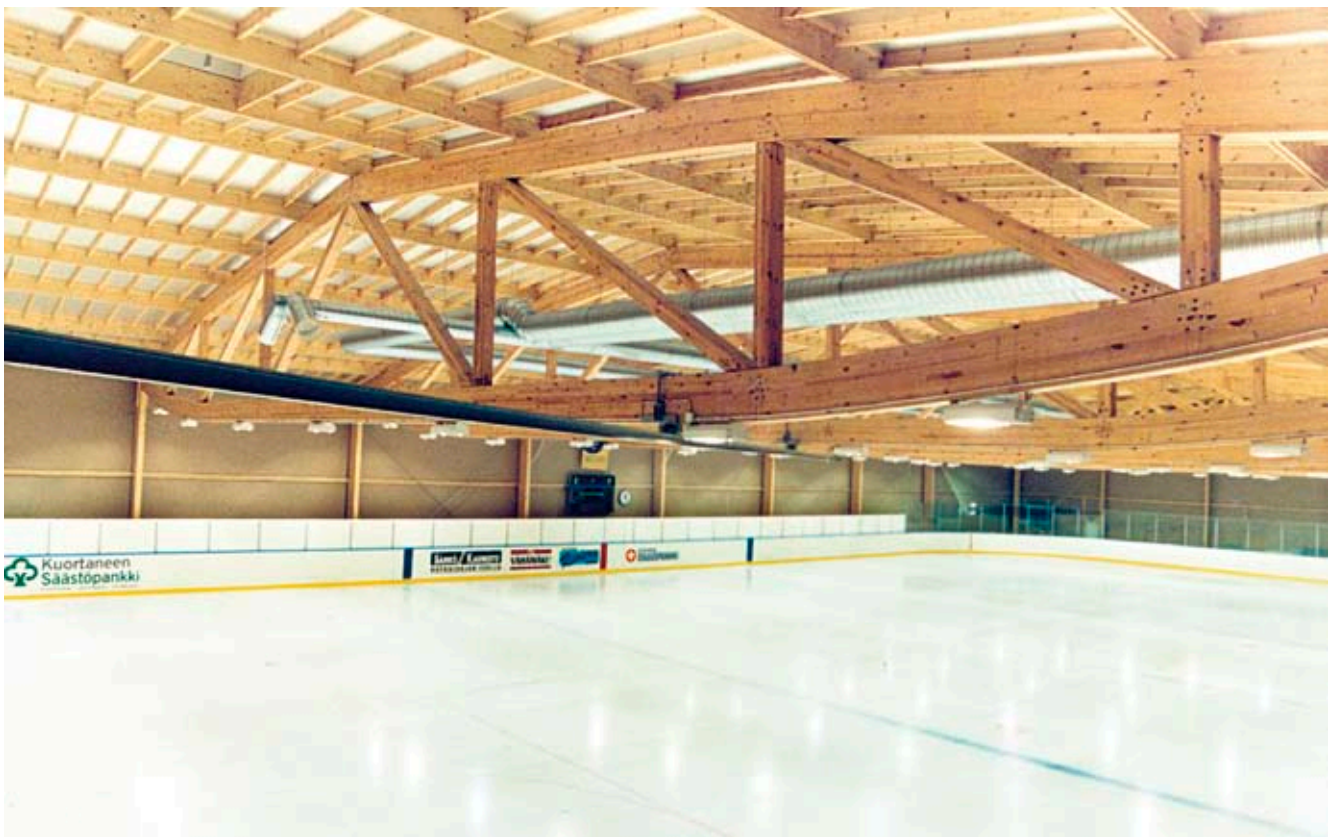
Kuva 5.8 Kuortaneen jäähallissa on käytetty ristikkokannattajia, joiden ansiosta halli on miellyttävän ilmava.
