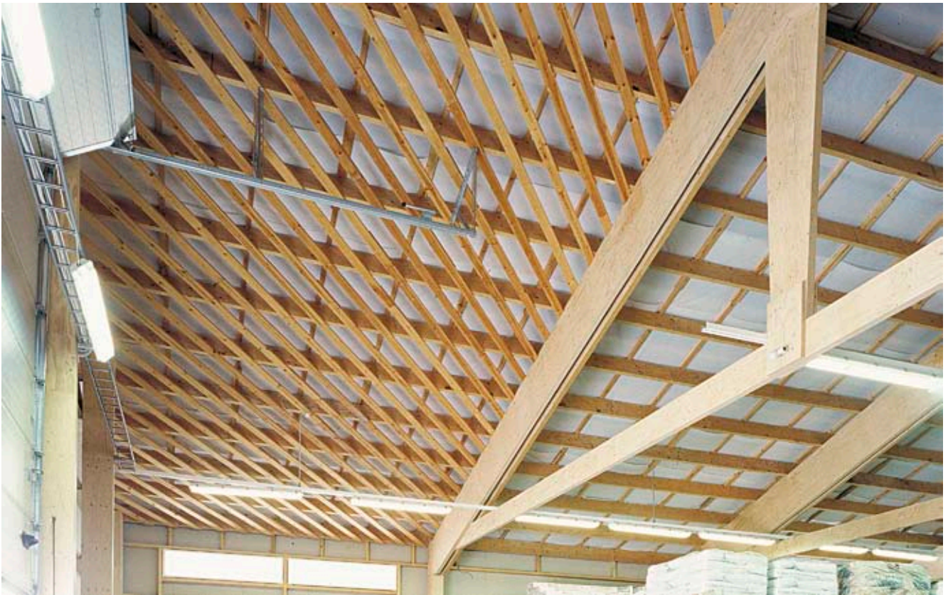
Kuva 10.15 Myymälärakennuksen vinojäykistettyjä kertopuukonstruktiotia.
