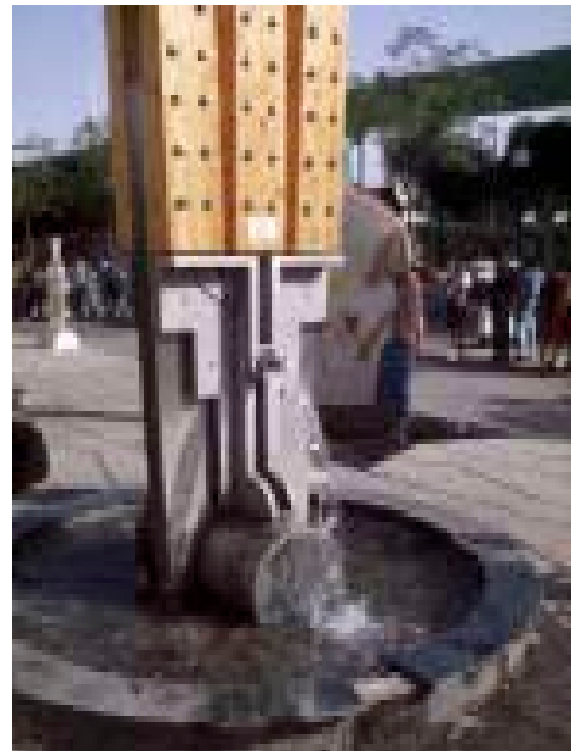
Kuva 8.4 Sevillan maailmannäyttelyssä vesi oli yleinen aihe. Liimapuupilari on nostettu teräsrakenteella ylös vesialtaasta.
