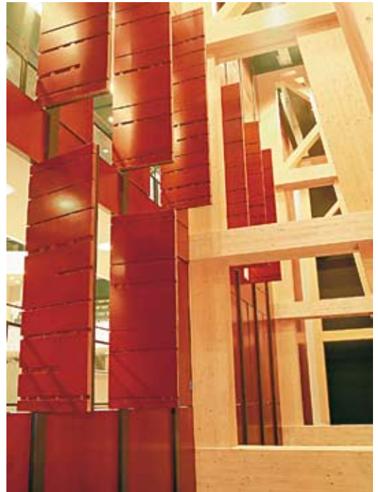
Kuva 4.7 Sibeliustalon vaativia rakenteita.
