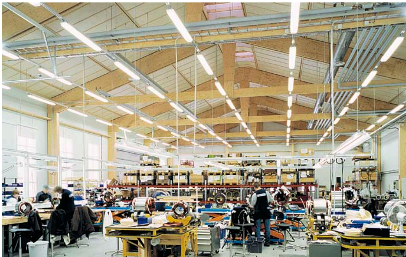
Kuva 10.13 Viilupuusta valmistetut A-kattokannattajat tarjoavat avaran ja valoisan tunnelman työtiloihin.
