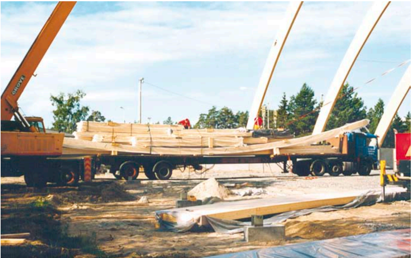
Kuva 3.2 Puuhalli on saapunut työmaalle. Esivalmistettujen rakenteiden kokoaminen käy nopeasti.
