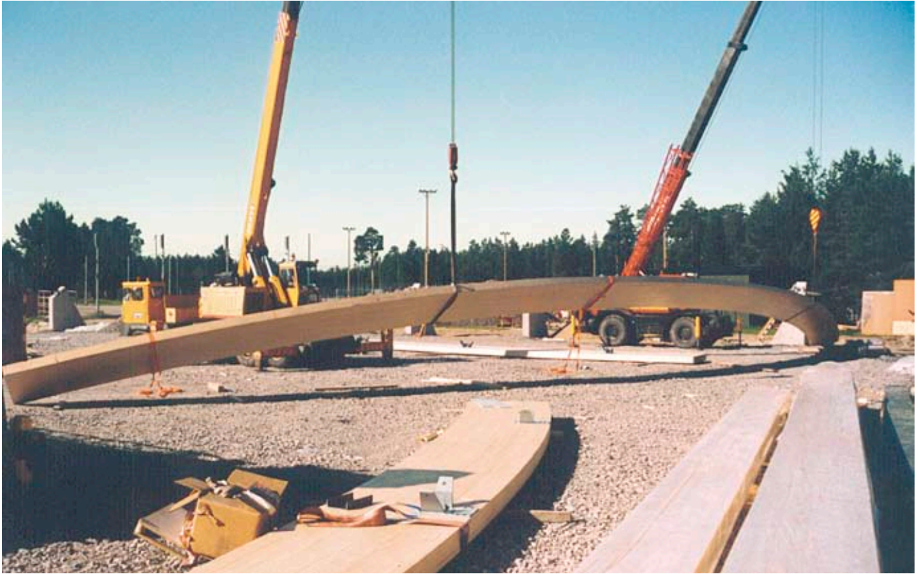
Kuva 3.3 Puuhallin kokoaminen jatkuu.
