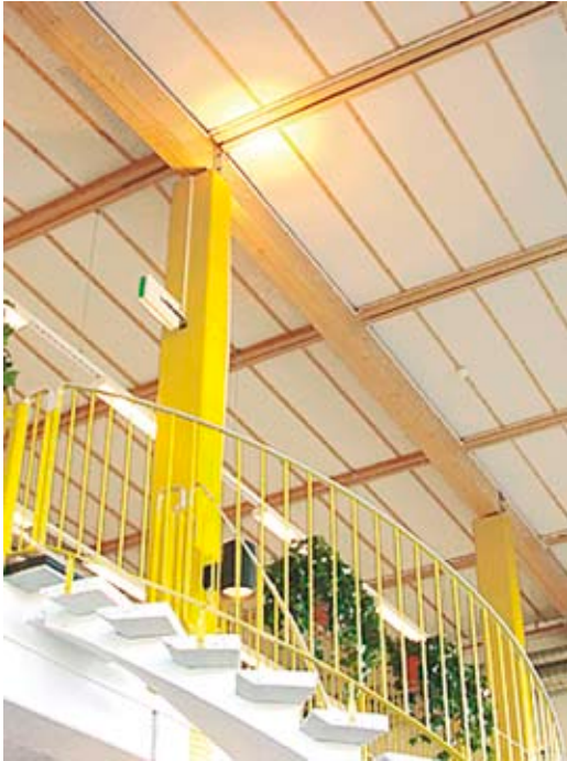
Kuva 6.5 Puinen yläpohjarakenne tarjoaa sellaisenaan ratkaisun äänenvaimennukseen. Mikroautorata VM Karting Center, Vantaa.
