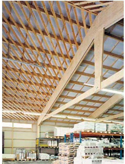
Kuva 4.5 A-kattokannattajat teollisuushallirakaisussa.
