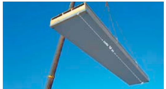
Kuva 10.16 Kertopuiset ripalaattaelementit mahdollistavat nopean asennuksen.
