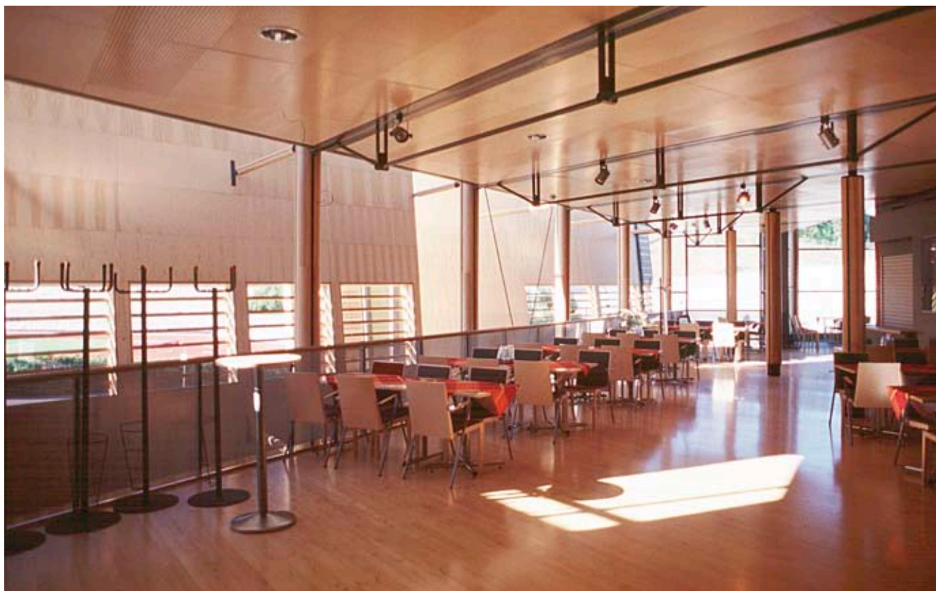
Kuva 2.25 Lahden hiihtomuseon ravintolassa on käytetty edustavasti ja monipuolisesti puuverhouksia.
