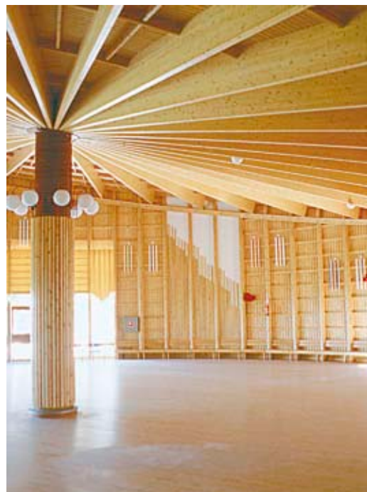
Kuva 2.28 Tykkimäen tanssipaviljongissa tilan tehokas käyttö yhdistyy puurakenteen muodostamaan miellyttävään sisätilaan.
