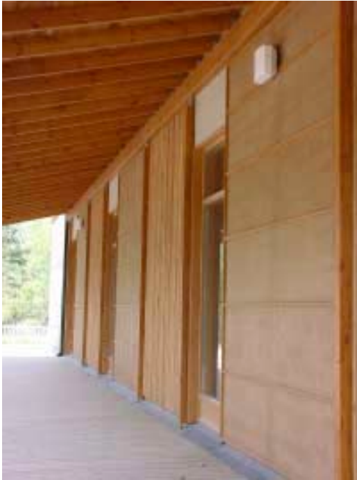
Kuva 6.3 Rakenteet on suojattava roiskevedeltä.
