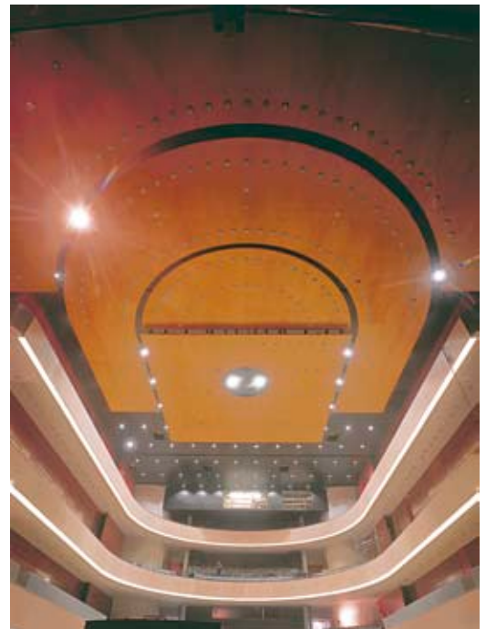
Kuva 10.20 Erilaiset vanerituotteet sopivat myöskin taivutettuina ja rei'itettyinä vaativan musiikkisalin akustisiin verhouksiin.
