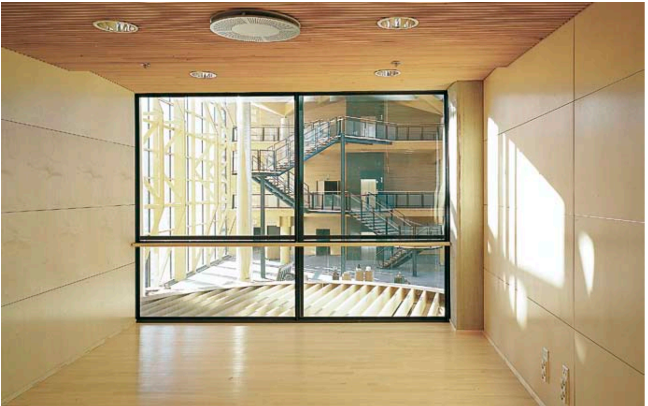
Kuva 10.19 Tyylikäs esimerkki vanerin käytöstä huonetilan verhouksmateriaalina.
