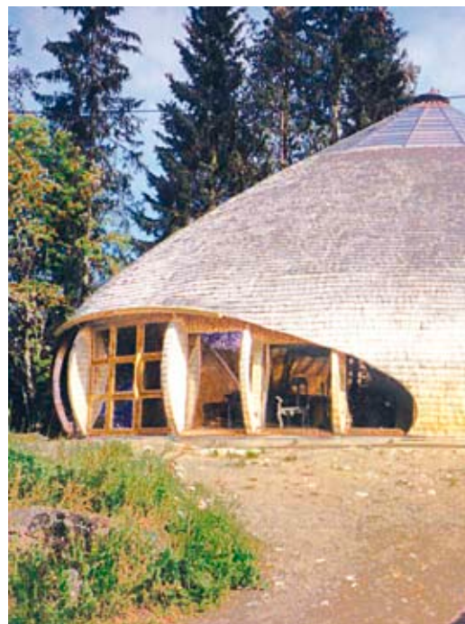
Kuva 2.4 Paikalla rakennettu tuotantohalli, jossa on tutkittu rakenteessa viivoitinpintoja. Wood-planet Oy, Vammala.
