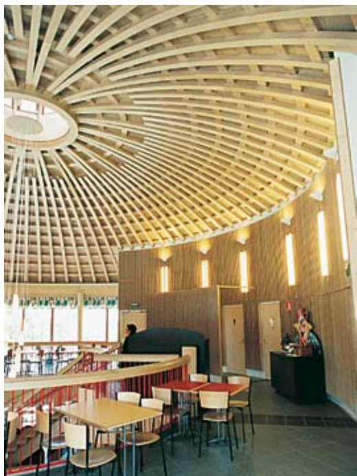
Kuva 2.26 Linnanmäen ravintolassa vanerista kehitettiin uudenlainen yläpohjaratkaisu.
