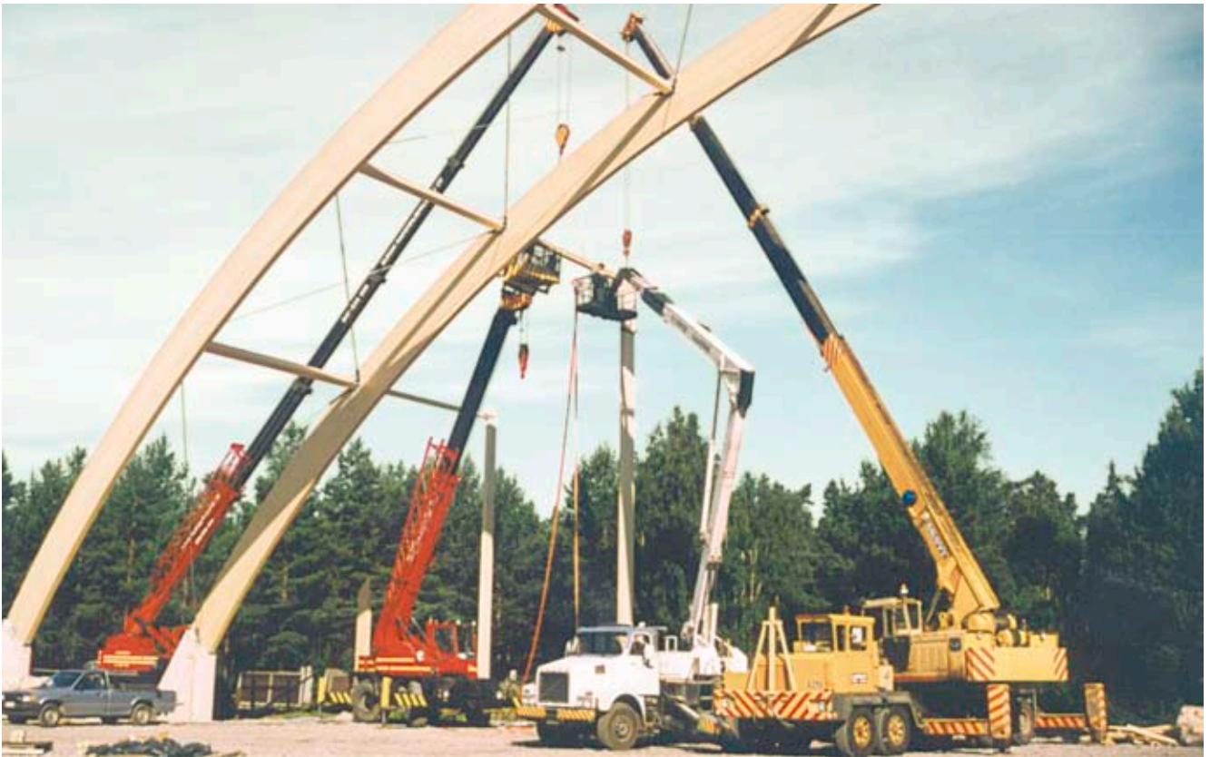
Kuva 3.4 Asennustyö käy nopeasti autonostureilla.
