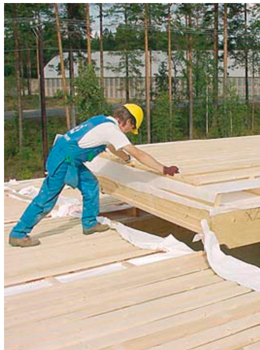
Kuva 6.4 Vesikatto voidaan toteuttaa tuulettavana tai suljettuna rakenteena.
