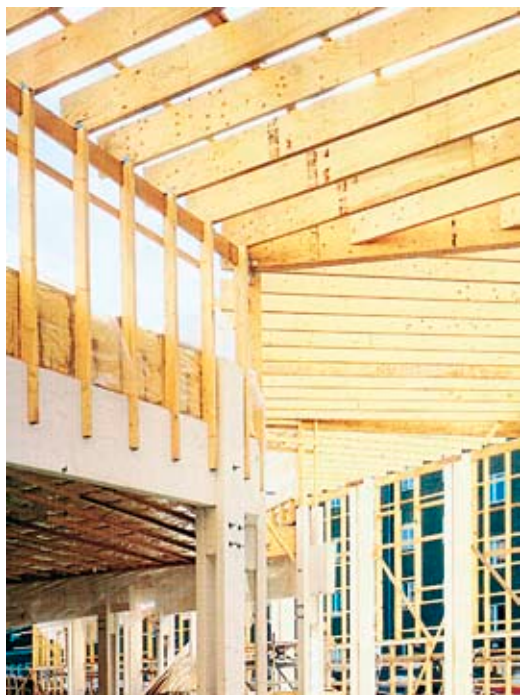
Kuva 10.14 Viilupuiset kannattajat asennusvaiheessa.
