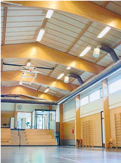
Kuva 6.7 Puu soveltuu monimuotoiseen käyttöön. Toinen esimerkki liikuntasalin äänenvaimennuksen toteuttamisesta.
