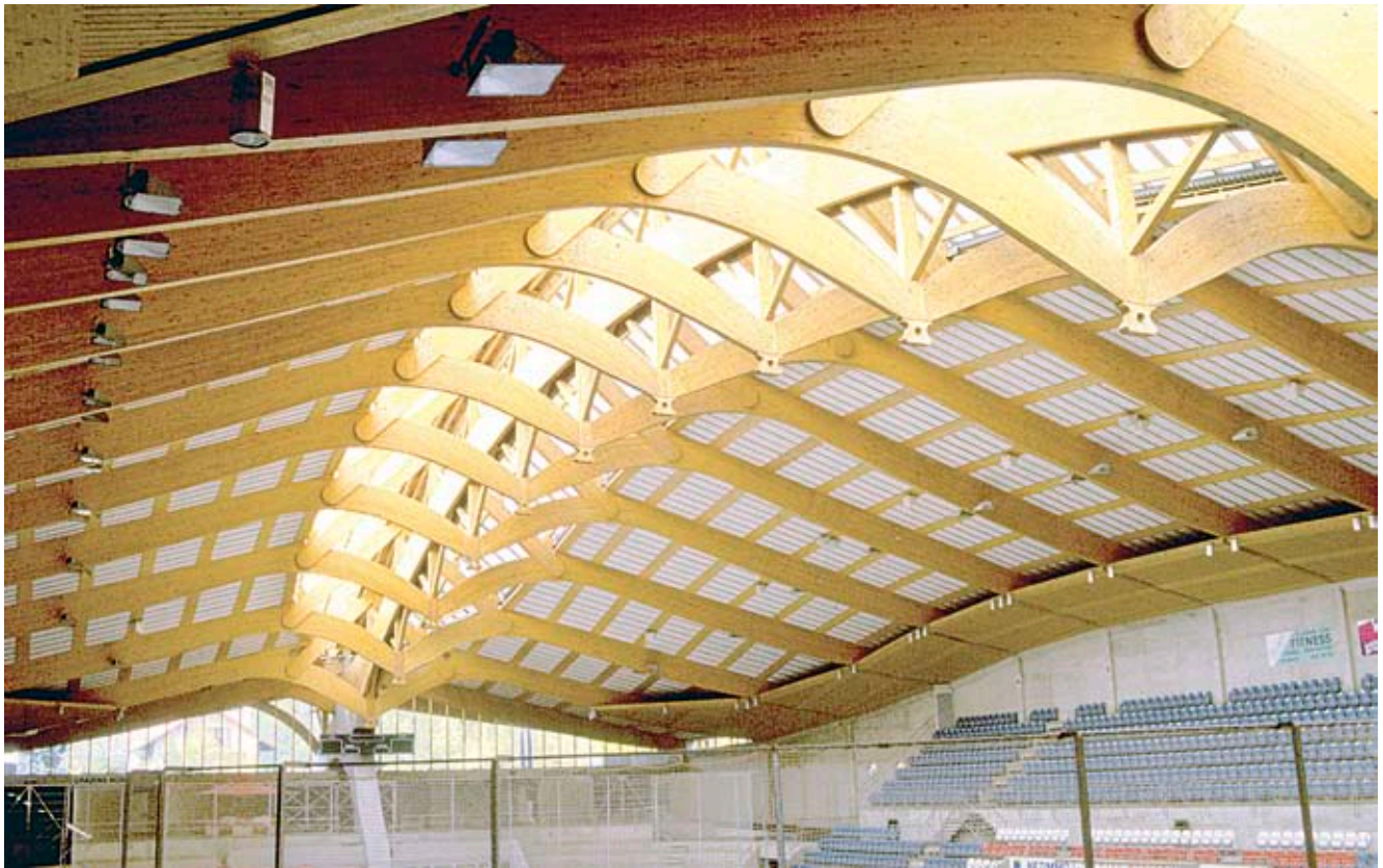
Kuva 2.17 Puu on mahdollista mukauttaa myös yksilöllisiin tarpeisiin. Kattovalon yhdistäminen osaksi rakennetta on mahdollista. Morges, Sveitsi.
