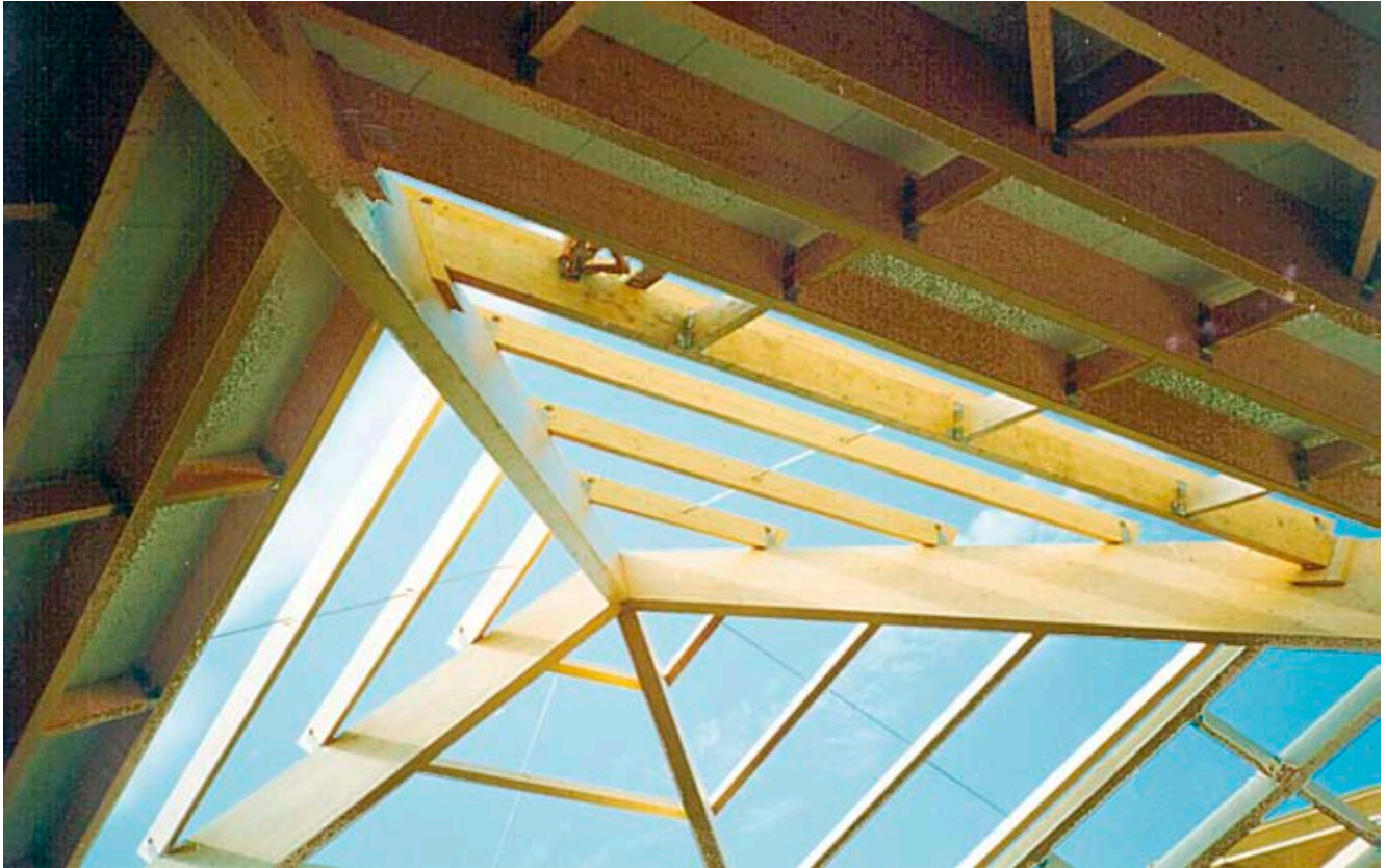
Kuva 4.6 Aina ei seinäpinnan läpi otettu suora valo ole toiminnan kannalta suotavaa. Pehmeätä ylävaloa luova kattolyhty on rakennettu liimapuupalkistolla.
