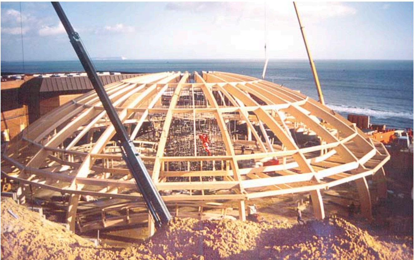
Kuva 5.23 Kupoliratkaisulla saavutetaan pitkiä jännevälejä.
