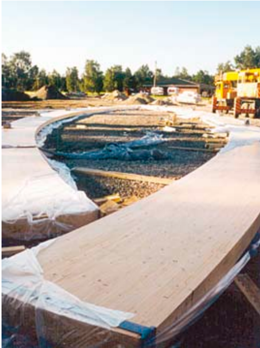
Kuva 3.6 Sääsuojaukset poistetaan vasta asennustyön yhteydessä.
