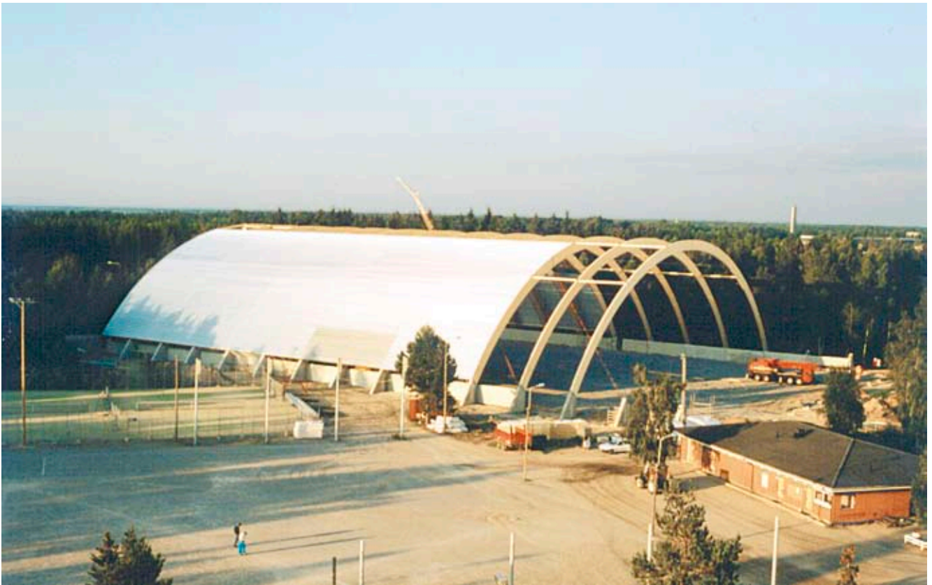
Kuva 3.10 Vaipan asentaminen on käynnissä.
