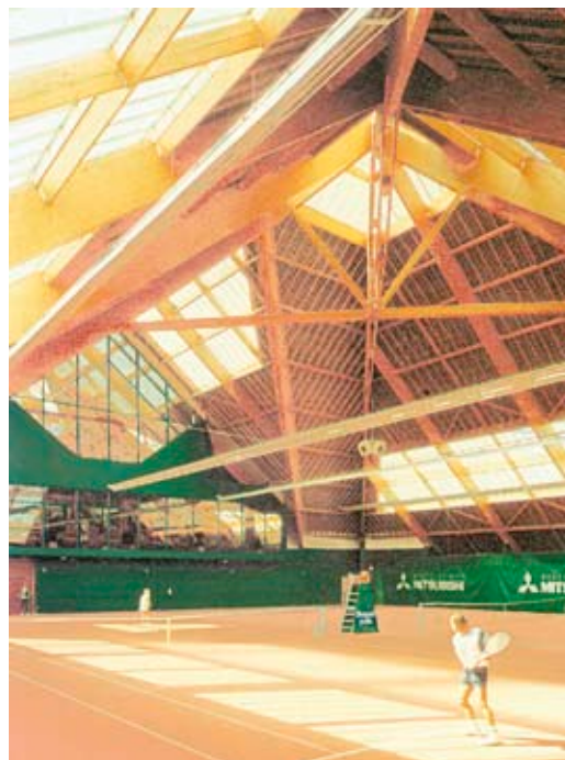
Kuva 2.12 Kaltevaan kattopintaan voidaan yhdistää kattoikkunat valoisuuden lisäämiseksi.
