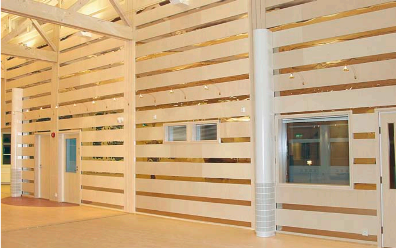
Kuva 6.8 Taidoikkailla äänenvaimennuksilla on luotu viihtyisää sisäiljöötä Isokyrön kirjastoon.
