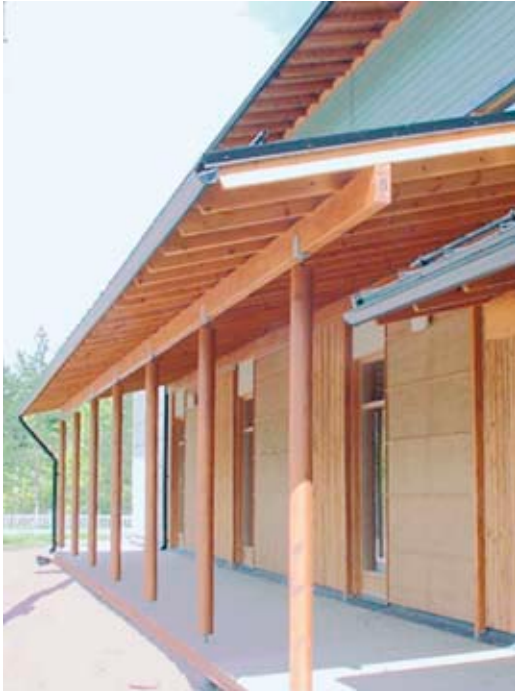
Kuva 3.19 Puupilarit ovat osa julkisivua.
