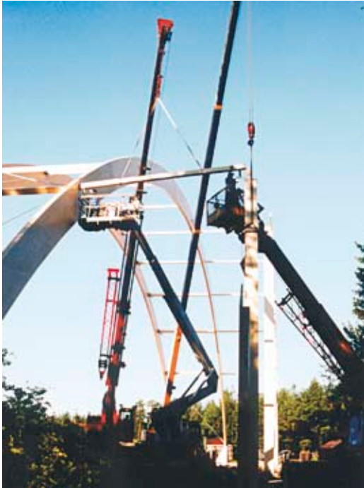
Kuva 3.8 Jäykistysristikon osien asennus on käynnissä.
