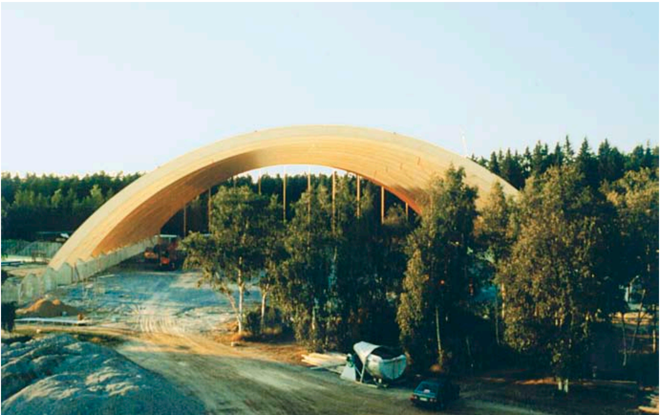
Kuva 3.9 Koko puurungon pystytys on saatu valmiiksi.
