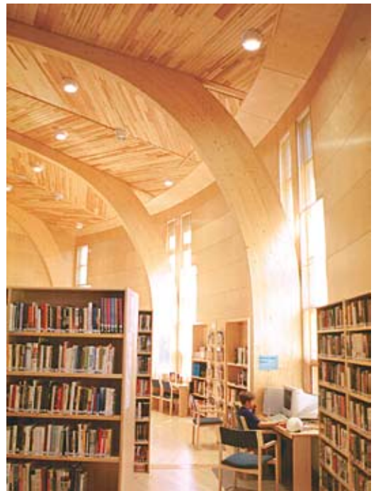
Kuva 3.18 Enon kirjaston interiööri. Pinnat on toteutettu vanerista luomaan lämmintä tunnelmaa. Pinnoissa on käytetty myös rei'itettyä vanerilevyä vaimentamaan tilaa akustisesti.
