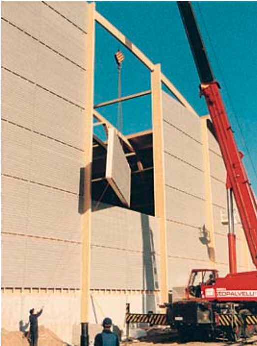
Kuva 6.17 Pirkkahallin seinäelementtien asennus käynnissä.
