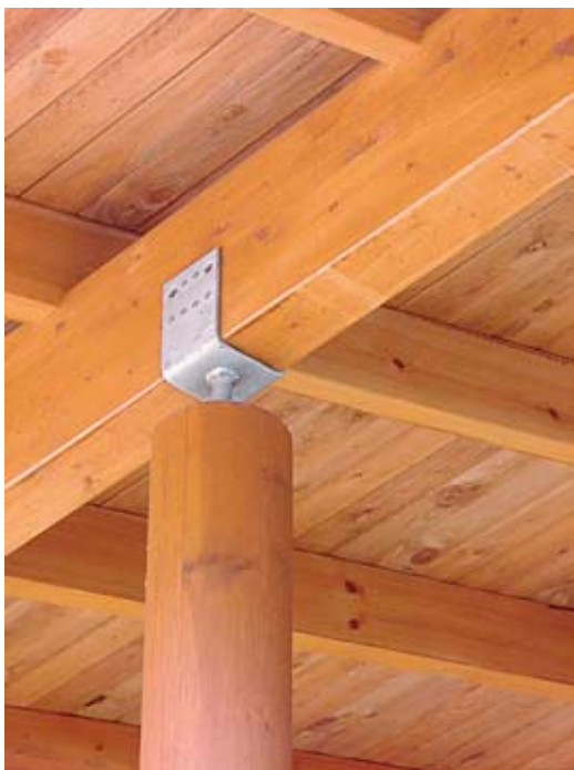
Kuva 9.2 Esivalmistettu liitososa, jolla liitoksen tekeminen sujuu nopeasti.
