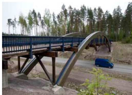
Kuva 2.32 Soidinpuiston kevyenliikenteen puusilta.
