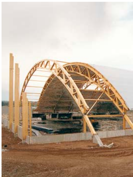
Kuva 2.10 Pirkkahallin ristikkokaaret tukevat sokkelin ulkopuolisiin betonianturoihin. Katto ja seinät rakennettiin puuelementeistä.
