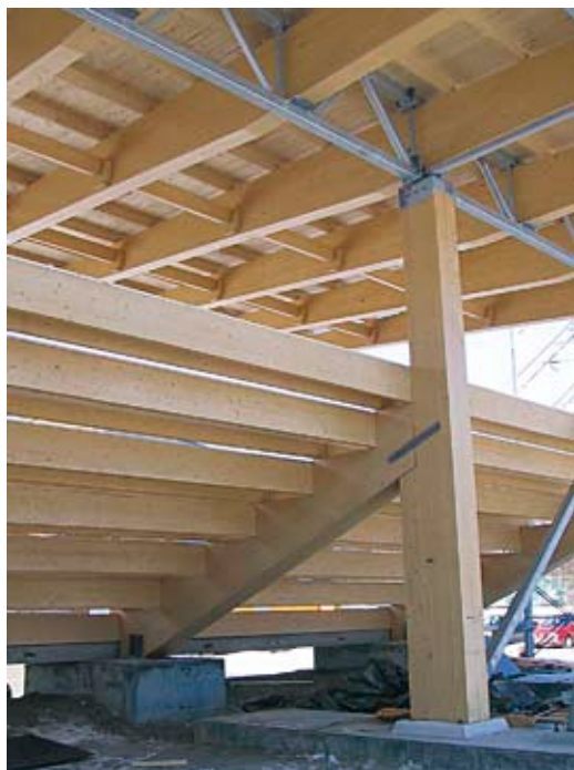
Kuva 8.2 Valkeakosken jalkapallostadionin katsomon perustuksia.
