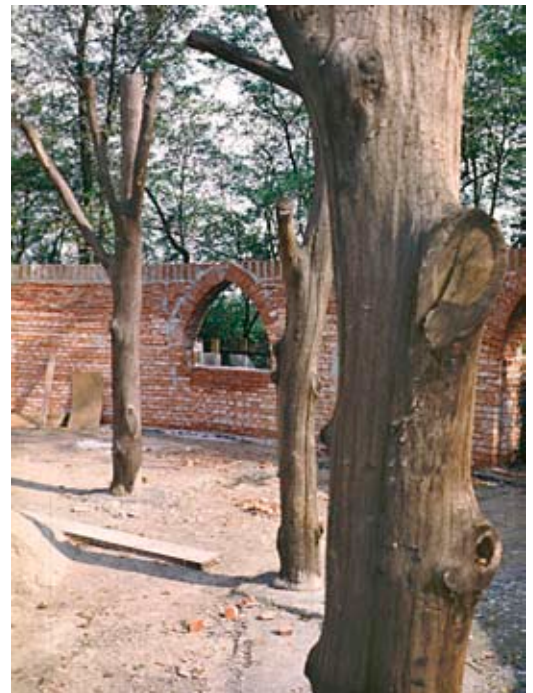
Kuva 3.22 Rakenteilla olevan näyttelyrakennuksen pilarit ovat kuorittua puuta oksineen. Unkarilaisen arkkitehdin Imre Makoveczin ideaa on sovellettu kymmeniin suuriin rakennuksiin.
