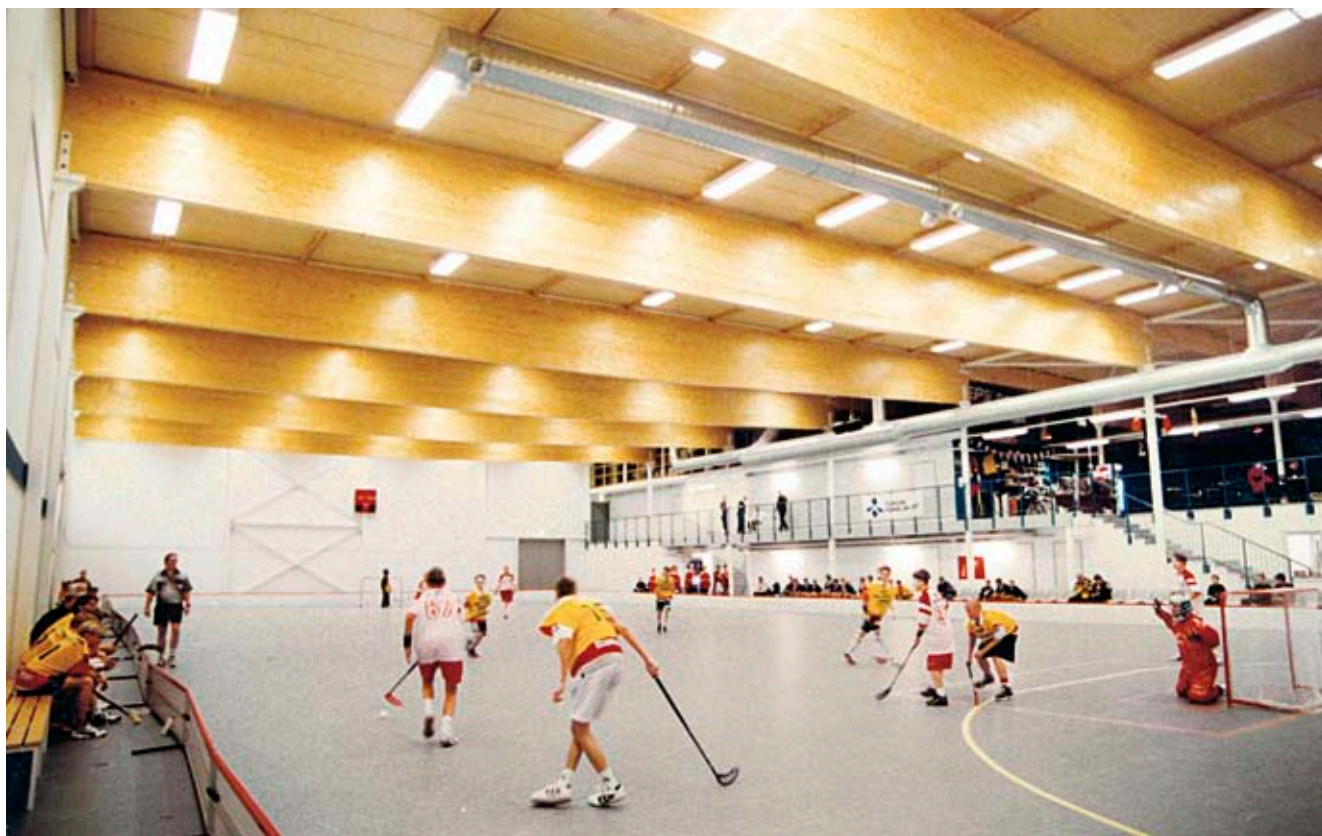
Kuva 2.11 Pilari-palkkijärjestelmä sopii hyvin palloilulajeille. Aktiivi-Arena, Turku.
