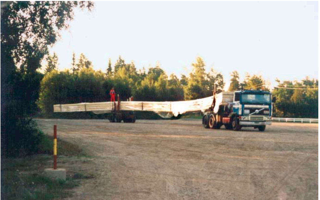
Kuva 3.1 Puuhallin matka alkaa. Liimapuukaaret kuljetetaan kuorma-autolla työmaalle.
