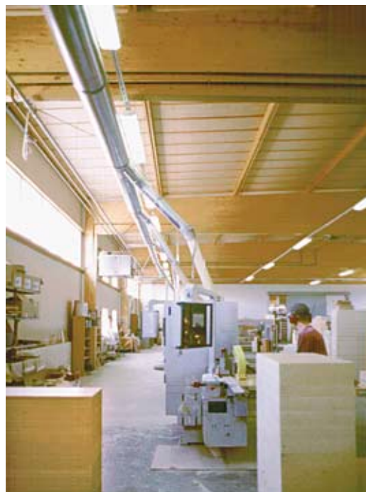
Kuva 2.20 Puuelementtivaippa toimii myös osana äänenvaimennusta. Kaluste-Team, Kauhajoki.
