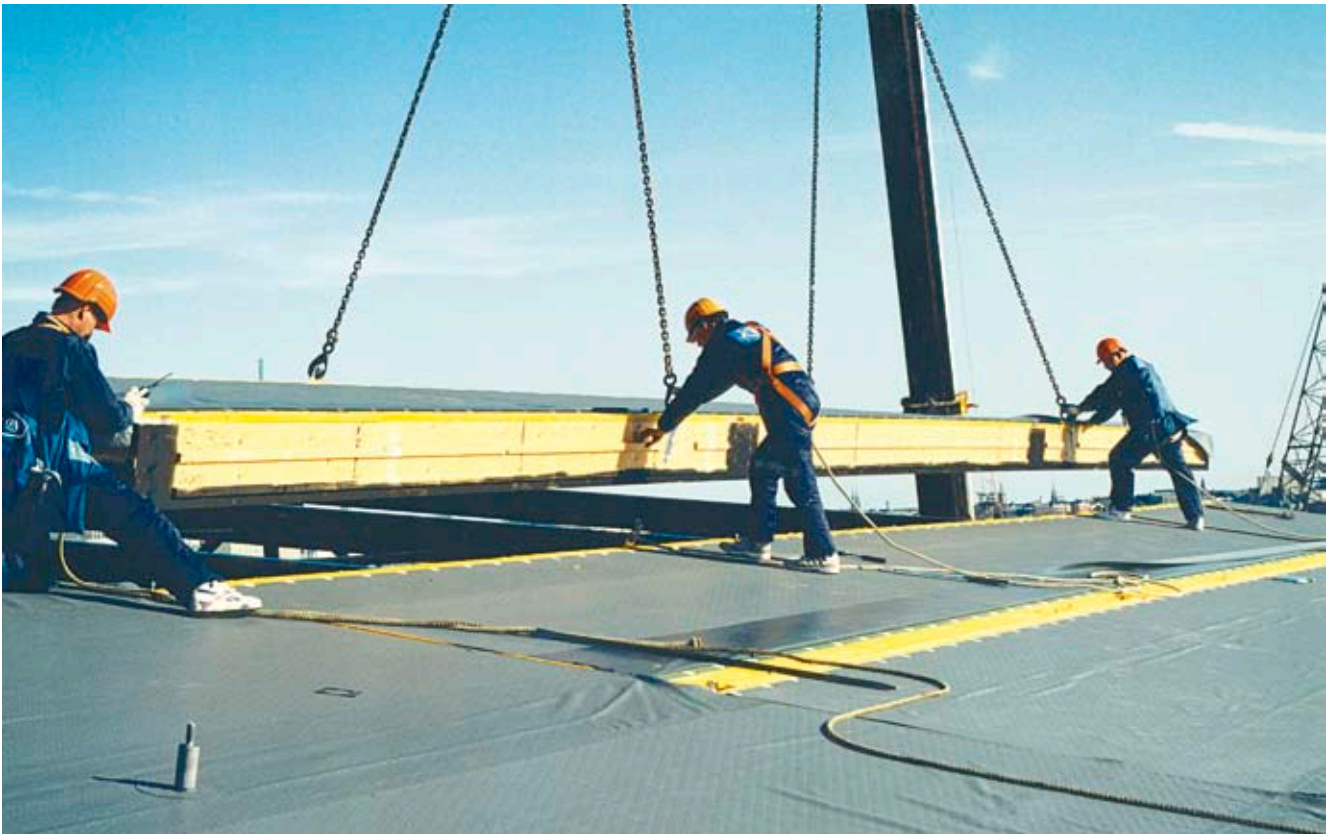
Kuva 4.1 Hartwall-areenan kattoelementtien asentaminen käynnissä.
