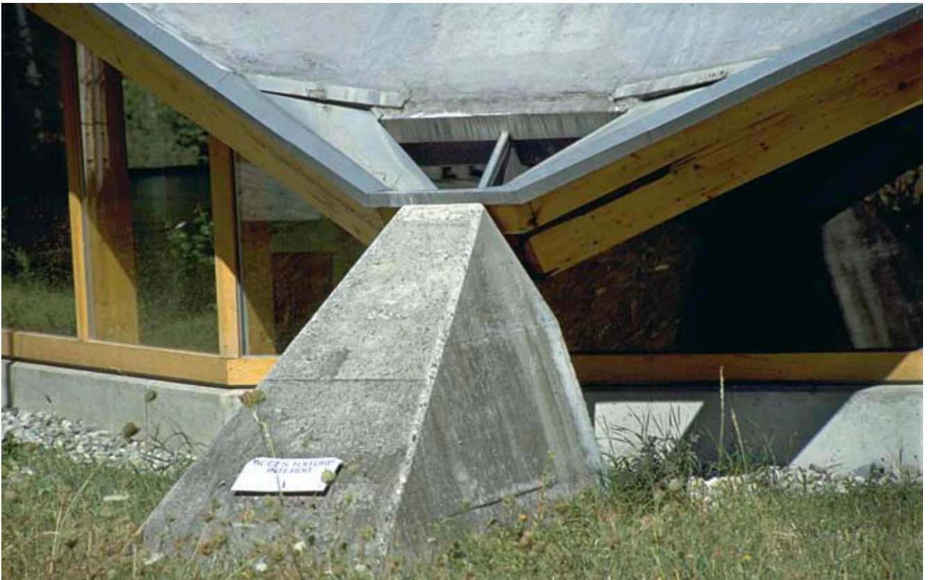
Kuva 8.3 Kaarirakenteisen hallin betoniperustus nostaa puurakenteen roiskevedeltä suojaan.
