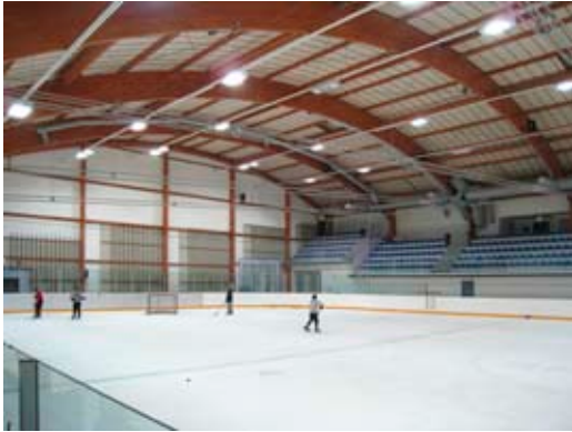
Kuva 7.2 Alavuden jäähallissa liimapuurungon värillä on saavutettu oma tunnelma.
