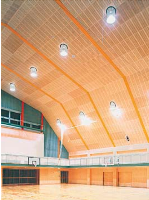
Kuva 6.6 Rei'itetyllä vanerilla toteutettu äänenvaimennus japanilaisessa koulun liikuntasalissa.
