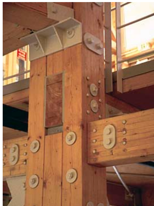
Kuva 9.4 Julkisen tilan liimapuurakenteiden mielenkiintoisia yksityiskohtia.
