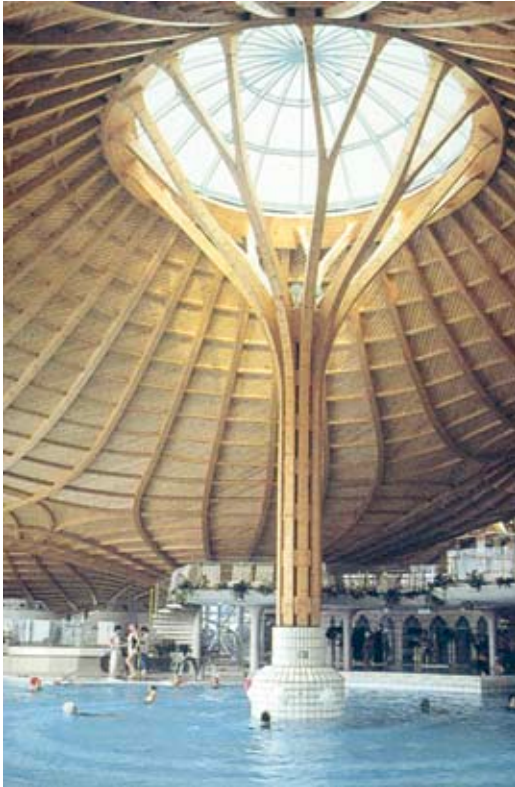
Kuva 4.3 Puurakenteinen kylpylä. Pilarin alaosaa on suojattu roiskevedeltä.
