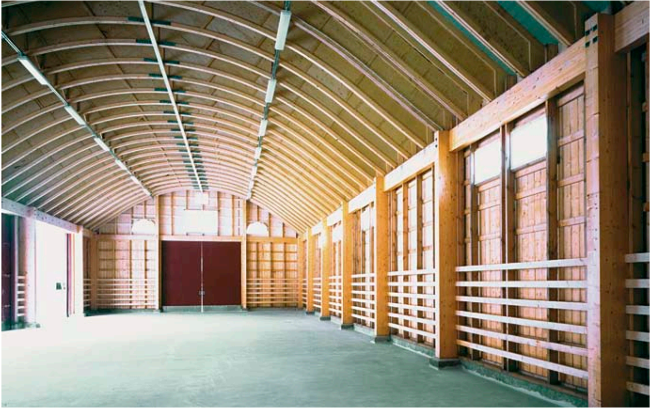
Kuva 2.21 Viikin varastorakennuksessa on vanerista tehty erittäin kevyt ja jäykkä yläpohjaratkaisu.
