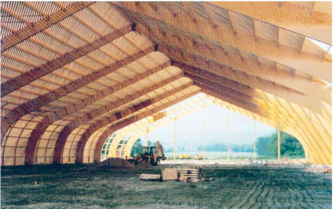
Kuva 5.19 Kolminivelkehän kaarevat nurkat luovat sisätilaan pehmeää ilmettä.
