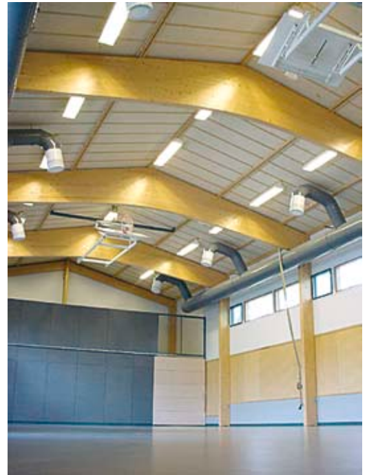
Kuva 3.21 Bumerangipalkki tarjoaa korkeutta keskellä hallia. Kankaanpään lukion liikuntasali.
