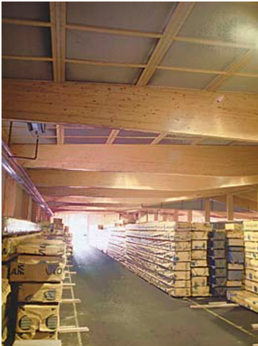
Kuva 2.22 Mahapalkit kaksilaivaisessa teollisuushallissa muodostavat erittäin tehokkaan tilaratkaisun.
