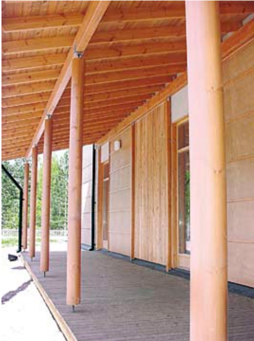
Kuva 6.1 Ulkoseinän liittyminen yläpohjaan räystäään alta katsottuna.
