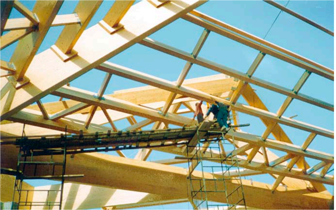
Kuva 3.25 Paikalla rakennettuja monimuotoisia puurakenteita.
