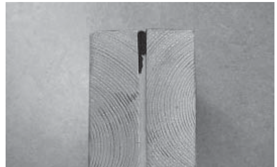
Kuva 115 a EPDM-solukumi + mineraalivilla pystyrakenteen saumassa.
