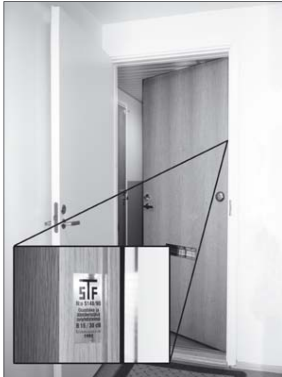
Kuva 50. Kahdesta erillisestä ovesta koostuva porrashuoneen ovi.
