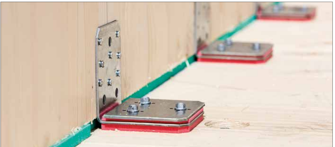
Kuva 53. Tärinäeristimet CLT-levyjen välisessä liittymässä. Kuva: Getzner.
