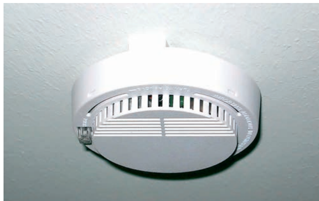
Kuva 64. Sisätiloihin tarkoitettu palovaroitin. Kuva: SPEK
