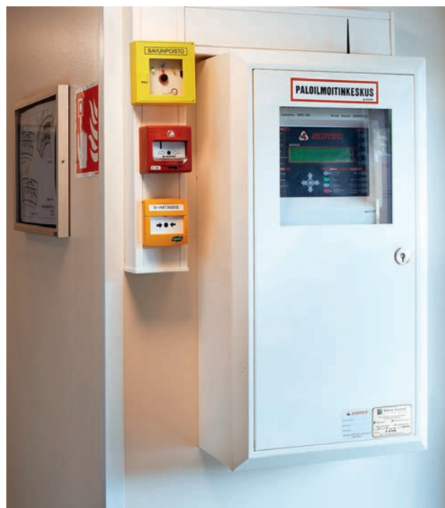
Kuva 66. Asuinkerrostalon paloilmointikeskus.
