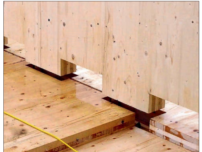
Kuva 92. Massiivipuulevyihin tehty hammastus siirtää tehokkaasti leikkausvoimaa ja pystykuormaa ilman teräsosia.
