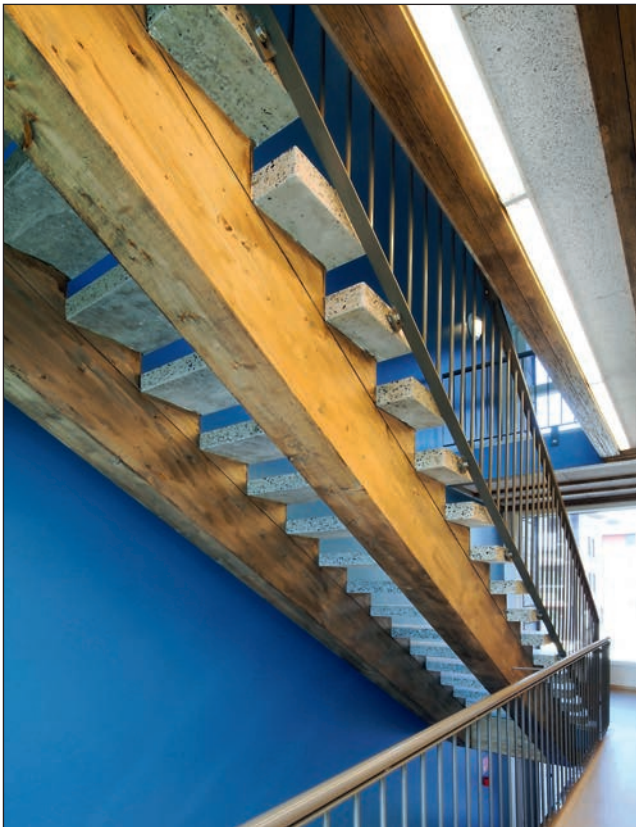
Kuva 60. Portaani B-s1, d0-luokan puurakenteiset kannatinpalkit eivät tarvitse suojaverhusta P2-paloluokan puukerrostalossa (vähäinen rakennusosa). Kuva: Metsä Wood
