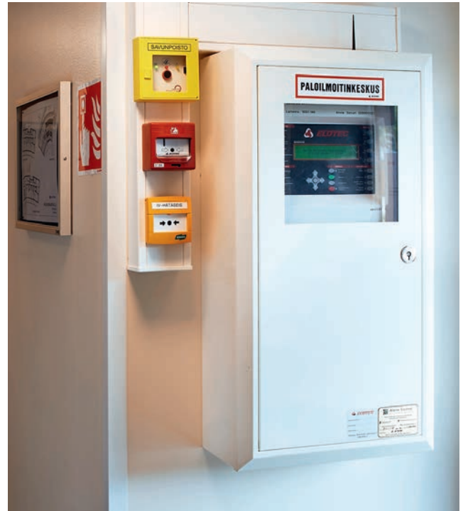
Kuva 66. Asuinkerrostalon paloilmointikeskus.
