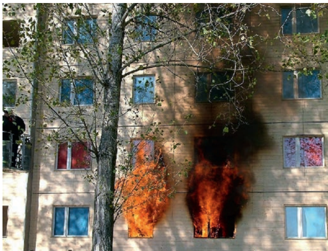
Kuva 1. Ikkunasta ulos tulevat liekit yltävät helposti yläpuolella olevan asunnon ikkunaan. Kuva: Pekka Nurro
