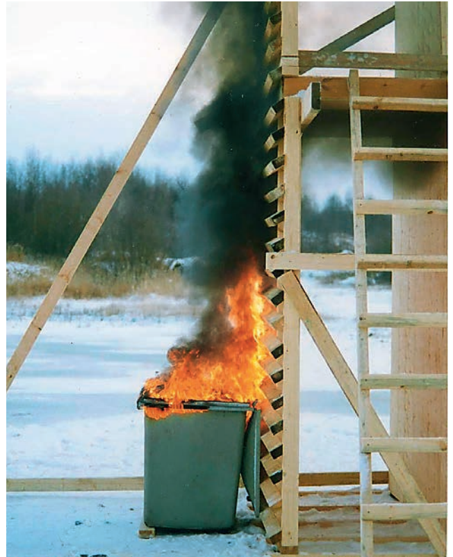
Kuva 40. Puuritolät ovat paloteknisesti haasteellisia. Kuva: Markku Karjalainen
