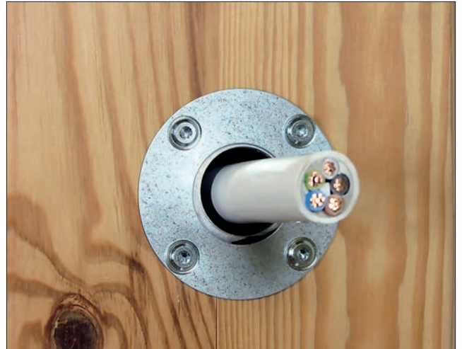
Kuva 54. Kaapeliläpivienti puurakenteessa (palomansetti). Kuva: Sewatek
