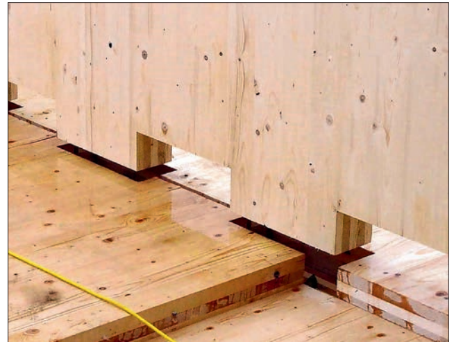
Kuva 92. Massiivipuulevyihin tehty hammastus siirtää tehokkaasti leikkausvoimaa ja pystykuormaa ilman teräsosia. Kuva: Willmott Dixon
