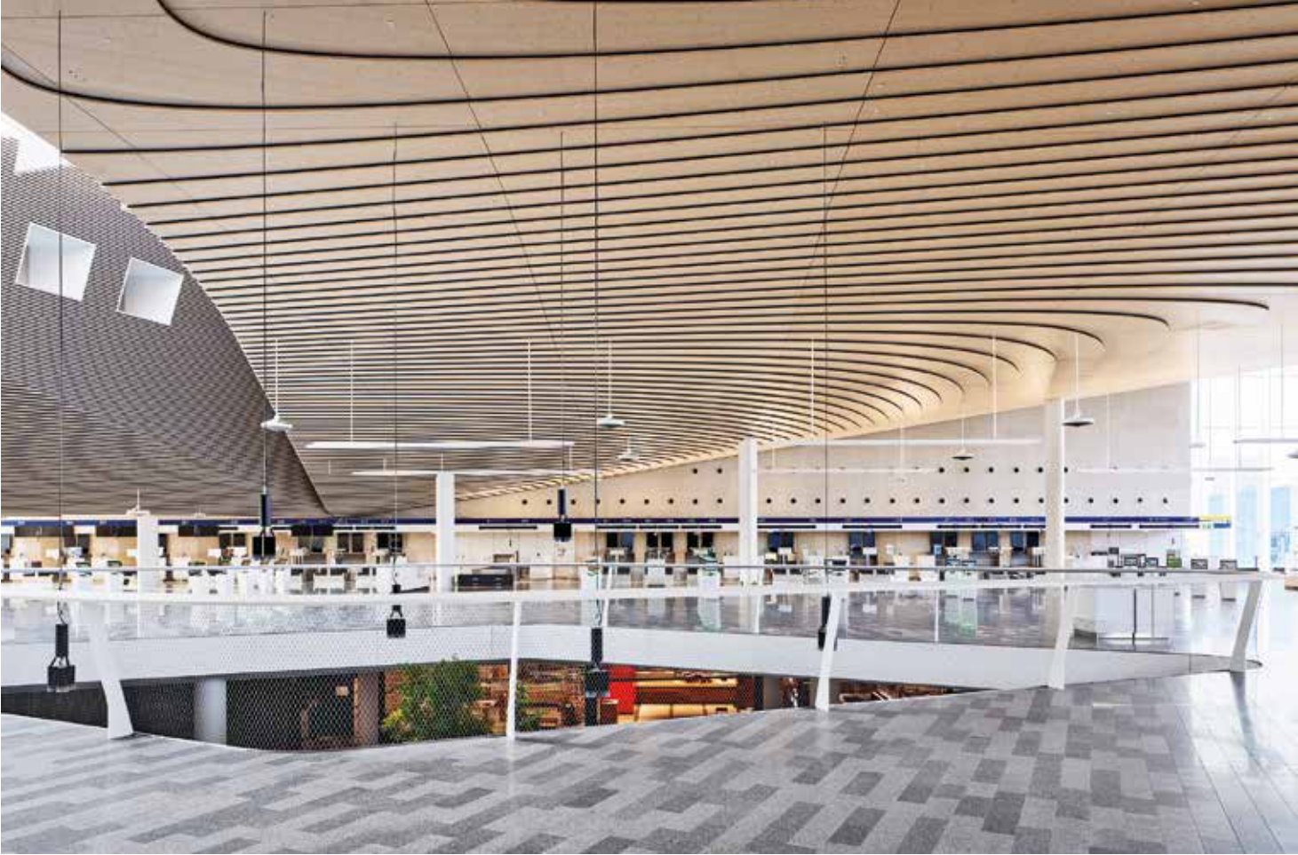
Jokainen alakattoelementti on yksilöllinen. Elementtien syysuunnat on huolella sovitettu katon geometriaan. | Each element of the wooden ceiling is unique. Wood grain has been matched with care to the geometry of the roof.
