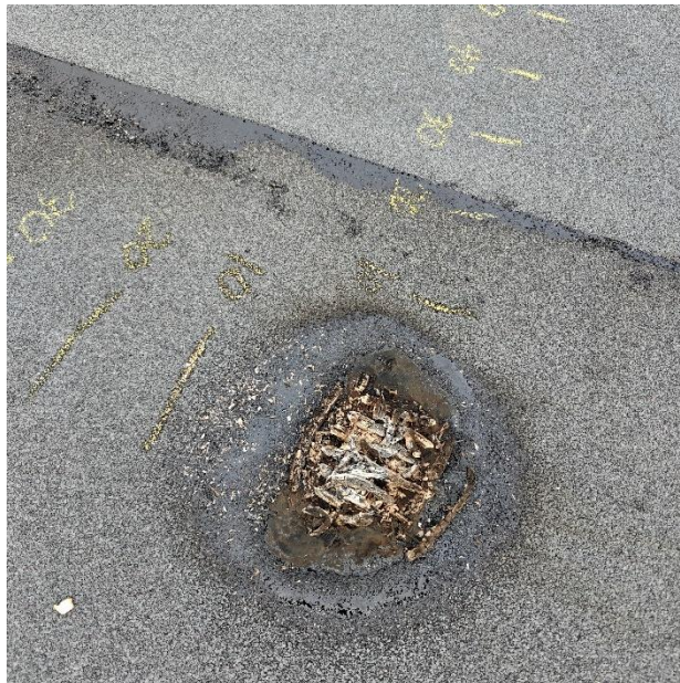
Kuva 6 – Palon leviämisen alue aurinkopaneelin alla yhdellä puutapulilla
