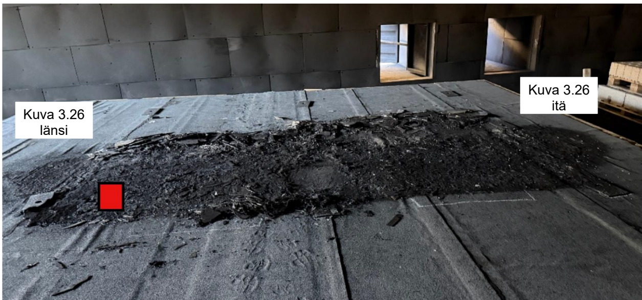
Kuva 3.25 – Koe 2 vaurioitunut alue
