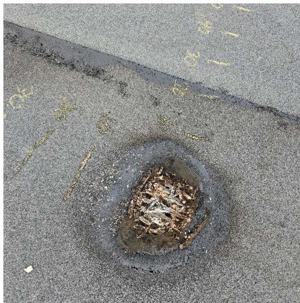
Kuva 6 – Palon leviämialue aurinkopaneelin alla yhdellä puutapulilla
